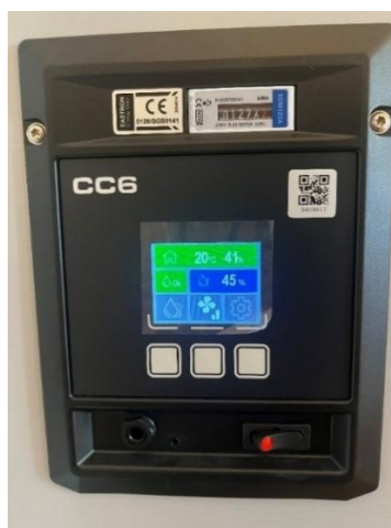
Figura 116: Monitorização dos Níveis de Humidade e Temperatura. © Martins, 21/01/2026.
