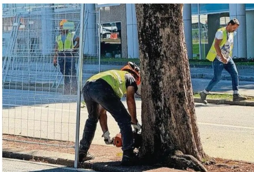
Figura 149 – “Obras do metrobus avançam com abate de árvores na Avenida da Boavista”. Fonte: Jornal de Notícias, 25/09/2025 [ID 201]. Disponível em: https://www.jn.pt/pais/artigo/obras-do-metrobus-avancam-com-abate-de-arvores-na-avenida-da-boavista/17957908
