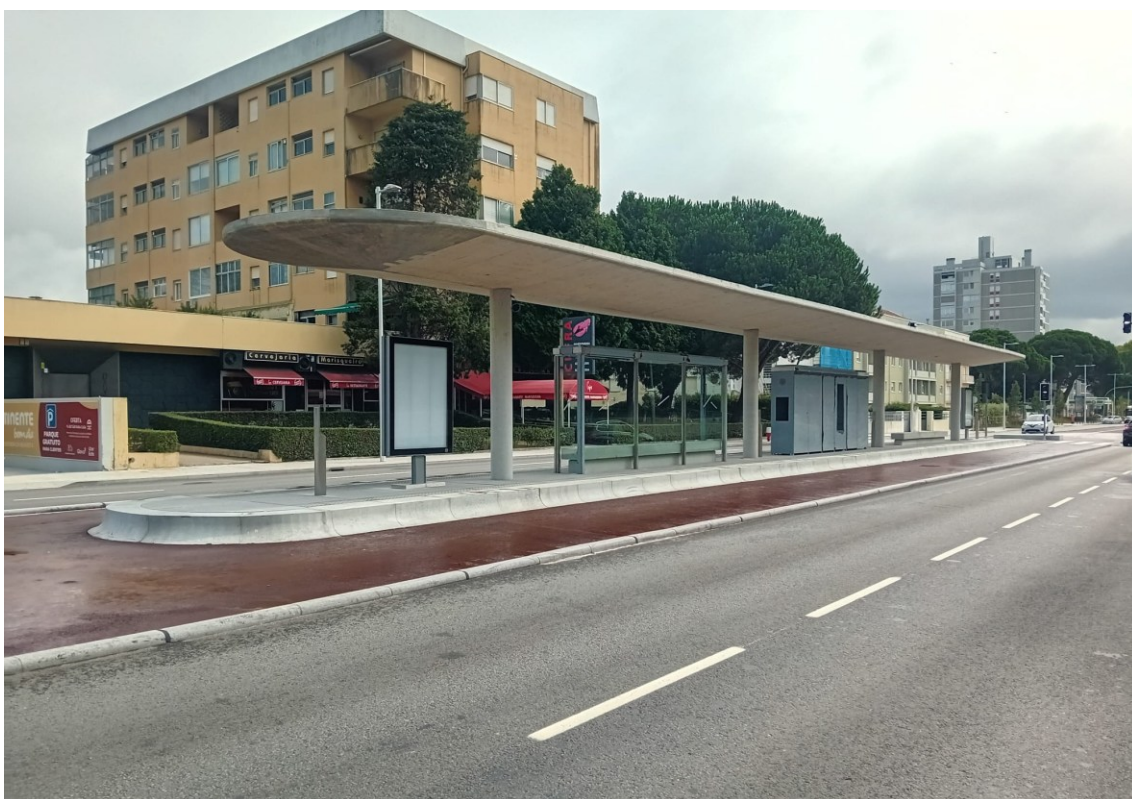
Figura 110– Fotografia da estação Pinheiro Manso, 2024, Fonte: Metro do Porto. Disponível em: https://www.facebook.com/photo/?fbid=910201974481496&set=pb.100064751045975.-2207520000
