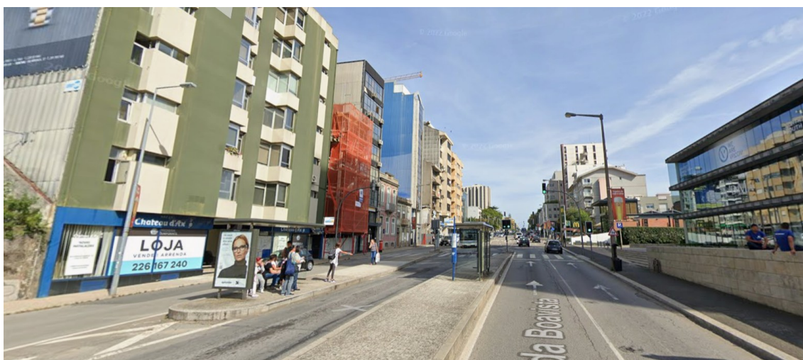
Figura 79 - Avenida da Boavista, junto ao Edifício Burgo, vista para nascente, 2019, Fonte: Google Street View (09/2019)
