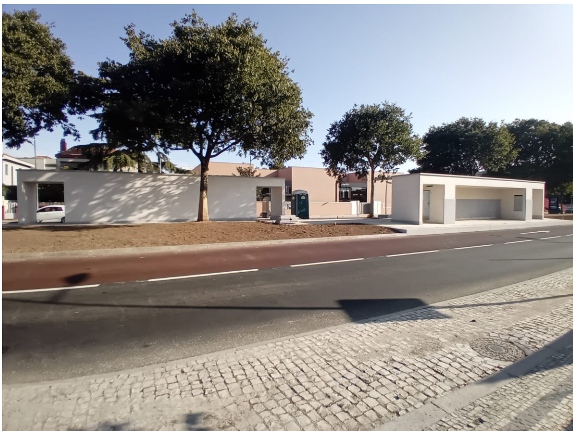
Figura 104 – Fotografia da Estação Serralves na Avenida Marechal Gomes da Costa, 2024. Fonte: Metro do Porto. Disponível em: https://www.facebook.com/photo/?fbid=910201914481502&set=pb.100064751045975.-2207520000
