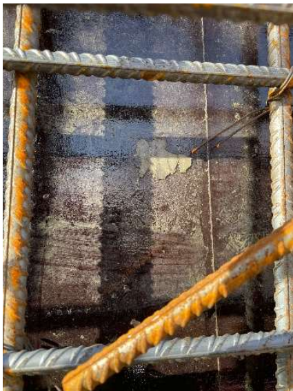
Figura 37 - Quantidade de óleo aplicada na cofragem em obra
