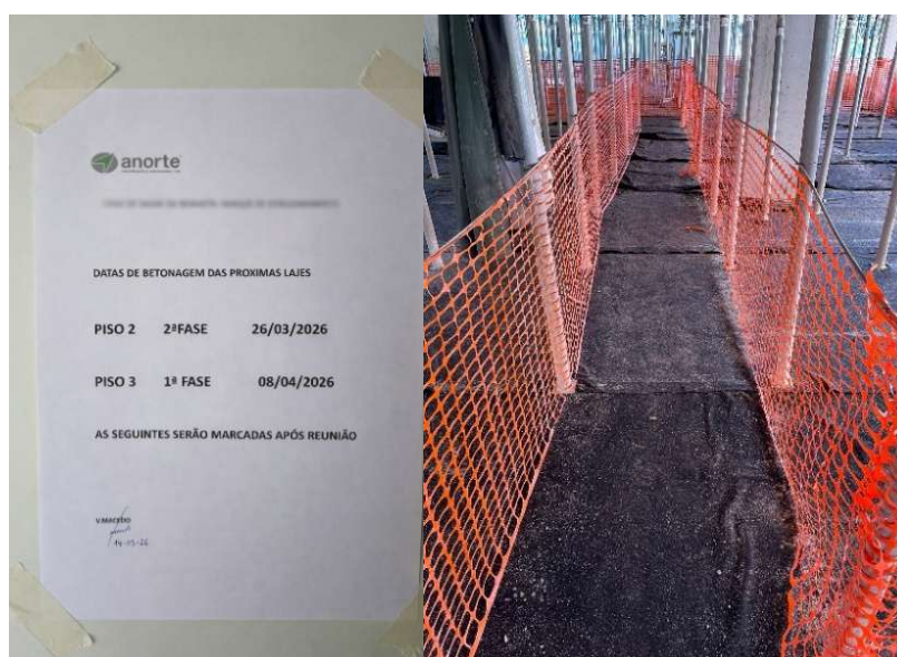
Figura 31 - Distribuição de informação acerca de Betonagem e Restrição de circulação em Obra (Controlo Visual)
