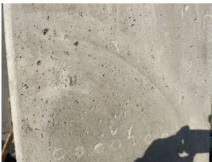
Figura 35 - Resultado da betonagem após a alteração das dimensões dos agregados (D16 para D22)
