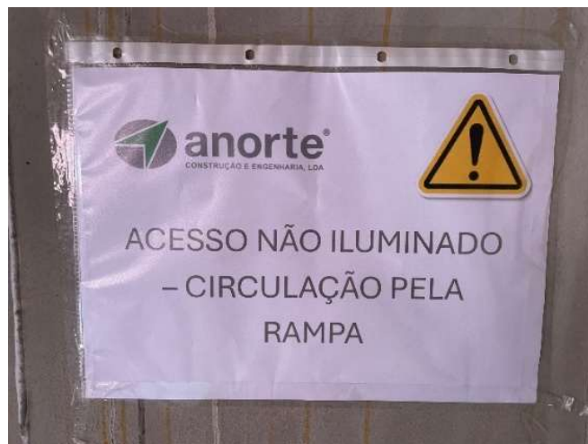
Figura 50 - Identificação de condicionante de acessos à obra
