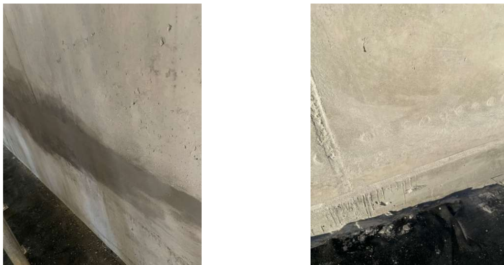
Figura 40 - Retrabalho para reparação da superfície de betão à vista
