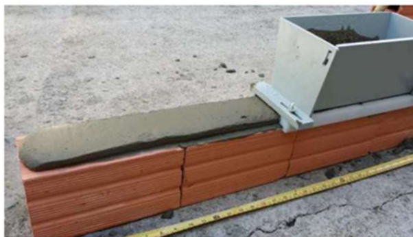
Figura 17 - Construção de alvenaria com processo uniforme - exemplo de Poka-Yoke [4]
