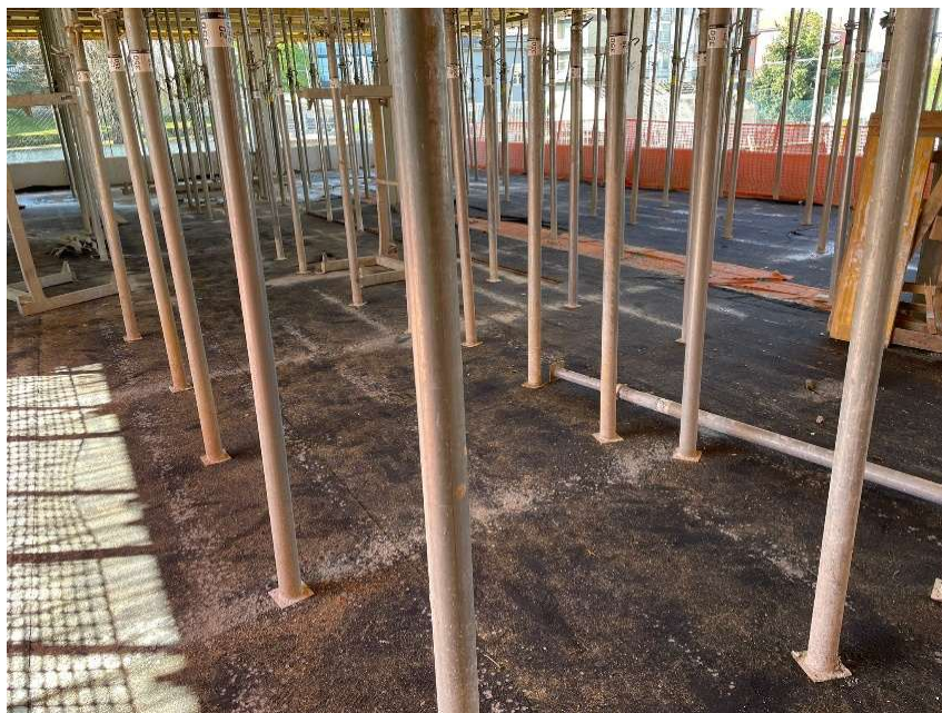
Figura 29 - Uso de alcatifa para proteção de piso em betão armado à vista (TQC, Seiketsu e Poka-Yoke )
