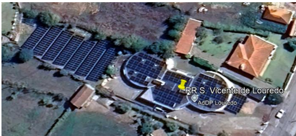
Fig. 6.4 - Painéis fotovoltaicos na cobertura da EE de S. Vicente de Louredo (imagem do Google Earth do dia 10 de outubro de 2025).
