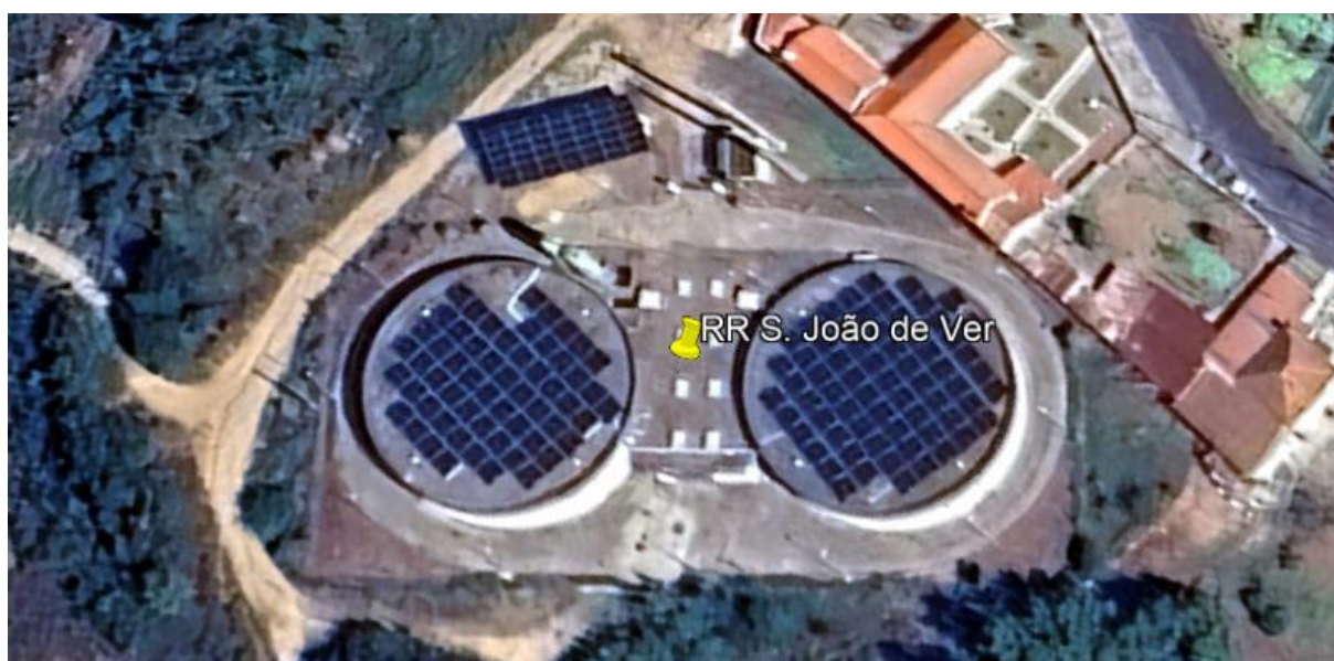
Fig. 6.3 - Painéis fotovoltaicos na cobertura da EE de S. João de Ver (imagem do Google Earth do dia 10 de outubro de 2025).
