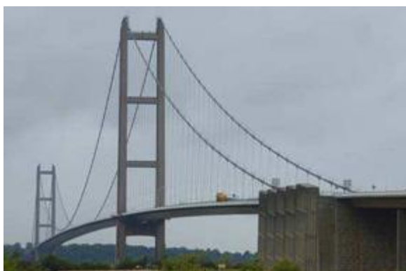
Figura 2.3 - Ponte de Humber, Reino Unido [2]
