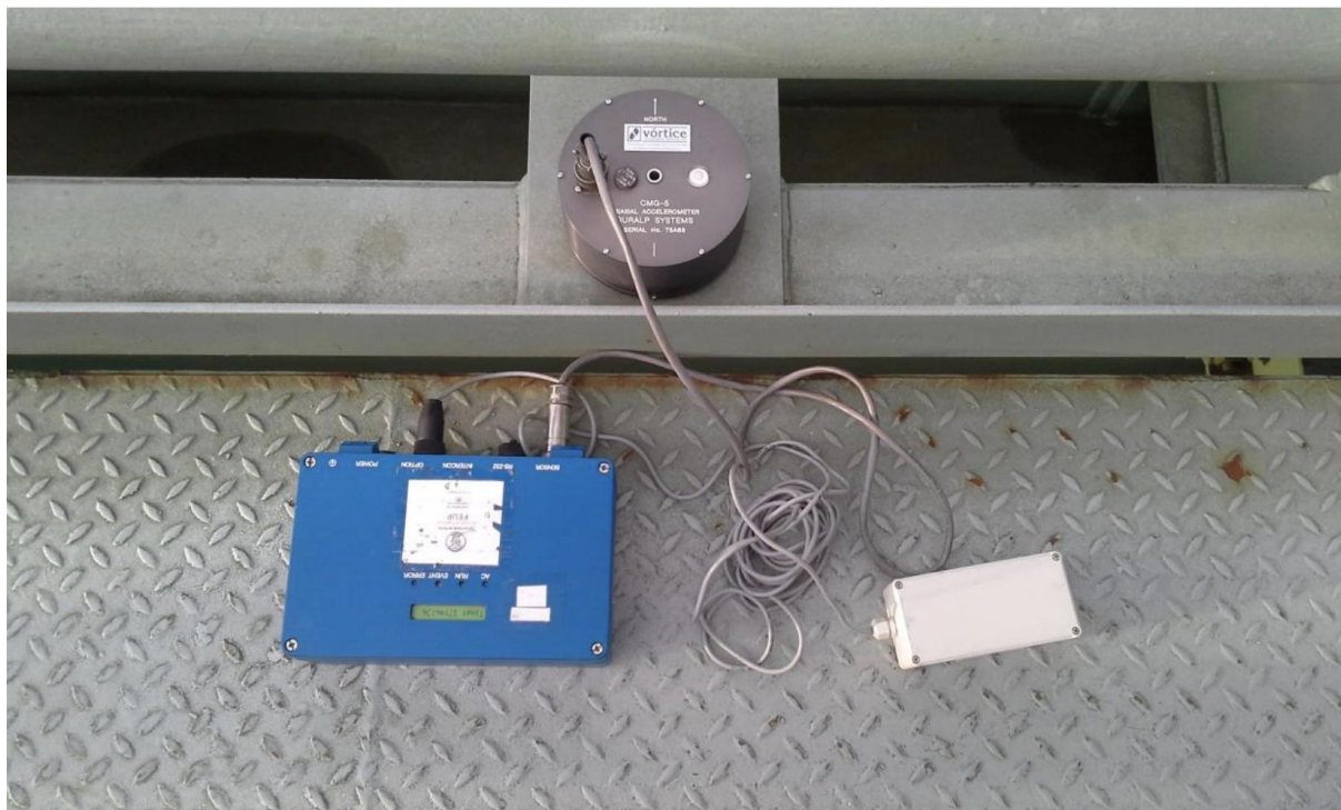
Figura 2.8 - Exemplo de uma estação de referência utilizada no ensaio da ponte, constituída pelos aparelhos
