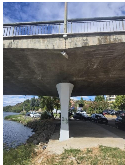
Figura 3.3 - Vista lateral longitudinal do Pilar
