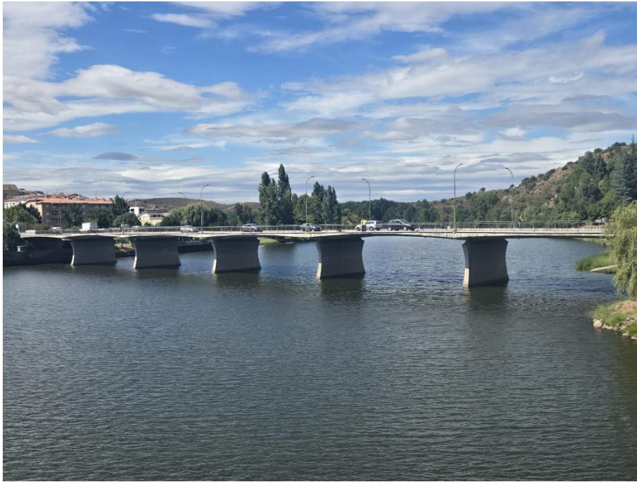
Figura 3.4 - Perspetiva da Ponte Engenheiro Machado Vaz
