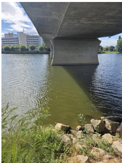
Figura 3.2 - Pilares da ponte erguidos sobre o Rio Tua
