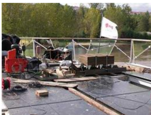
Figura 2.1 - Excitador hidráulico na ponte Pedro e Inês [2]
