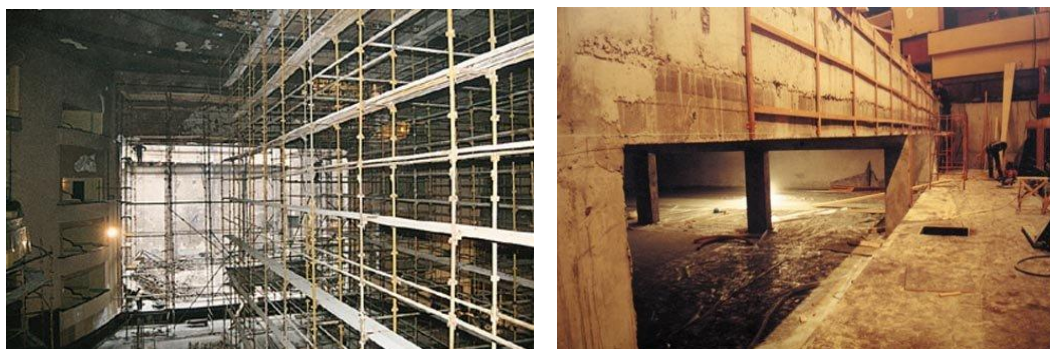
Figura 4.14 e 4.15 - Reconstrução do tecto e do fosso de orquestra, após o incêndio de 1996, na Sala Principal do Coliseu do Porto [43][45][49].
