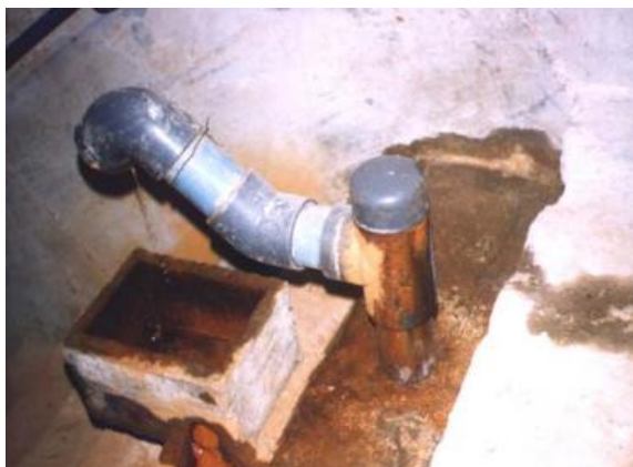
Figura 2.14 - Terminal de um dreno (Moura 2005).
