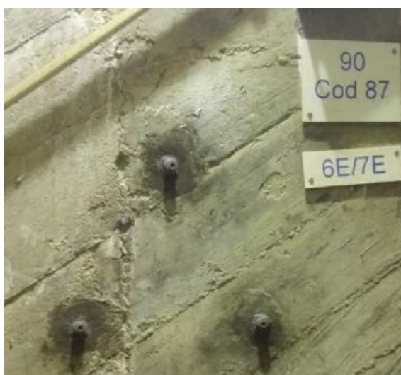
Figura 2.11 - Bases de alongâmetro no paramento do vazamento da barragem da Bemposta (Rebelo 2020).
