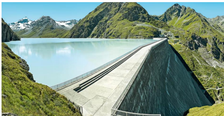
Figura 2.4 - Barragem Grande-Dixence – Barragem de gravidade (Switzerland Tourism 2026).
