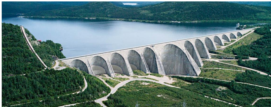
Figura 2.5 - Barragem Daniel-Johnson – Barragem de contraforte (Hydro-Québec 1996).
