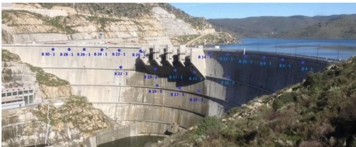
Figura 3.3 –Distribuição dos acelerómetros pela barragem do Baixo Sabor (Pereira 2019).
