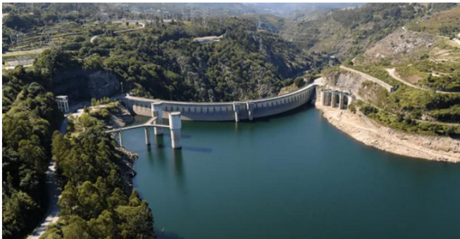
Figura 2.6 - Barragem do Alto Lindoso – Barragem em abóbada (EDP 2024).
