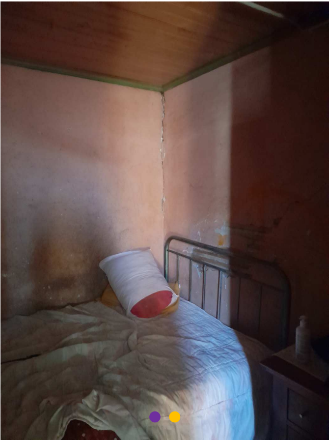
FIG.151. Situação existente. Quarto interior. FIG.152. Situação existente. Anexo da cozinha.
