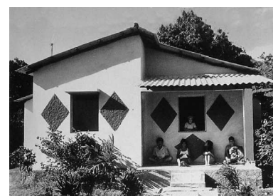
FIG.25. Construção de 68 casas em Hologuín. Cuba, 1999.
