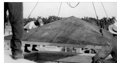
FIG.12. Descofragem das primeiras coberturas em betão armado.
