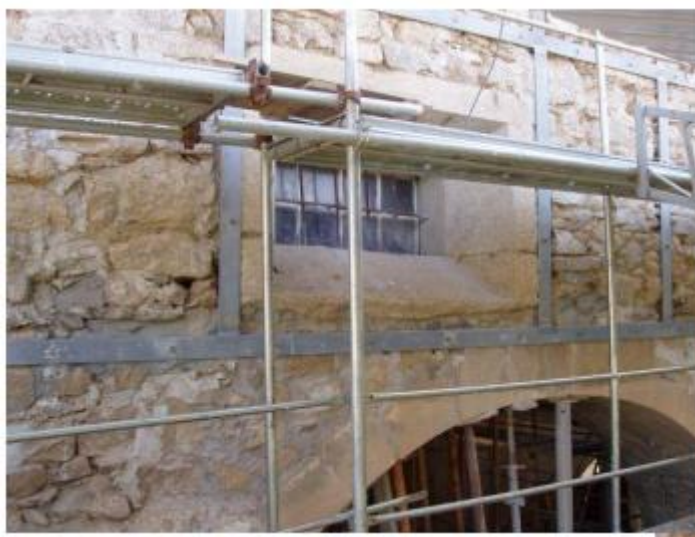
Figura 2.25 - Ancoragem da parede (Guedes, 2025b)
