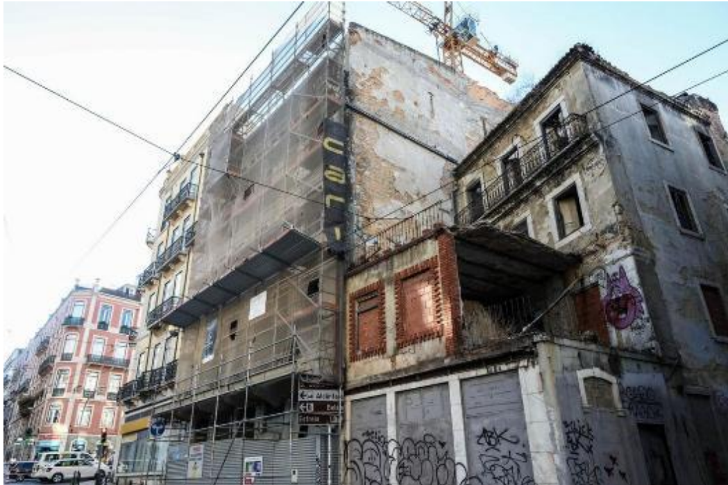
Figura 2.7 - Falta de manutenção, Sábado, 16 de abril de 2026, https://www.sabado.pt/
