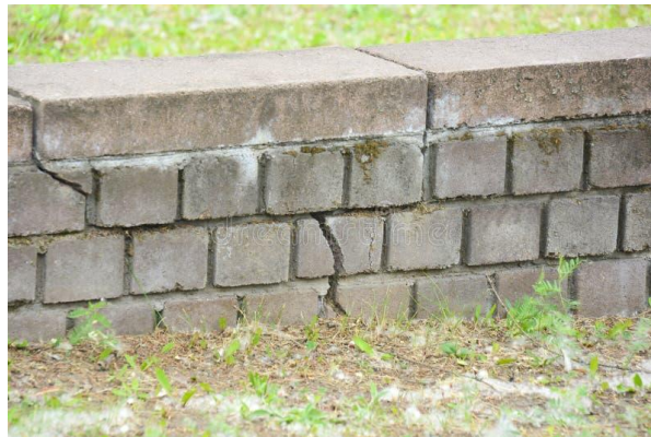
Figura 2.4 - Rotura localizada de bloco pétreo. (Dreamstime, n.d.)
