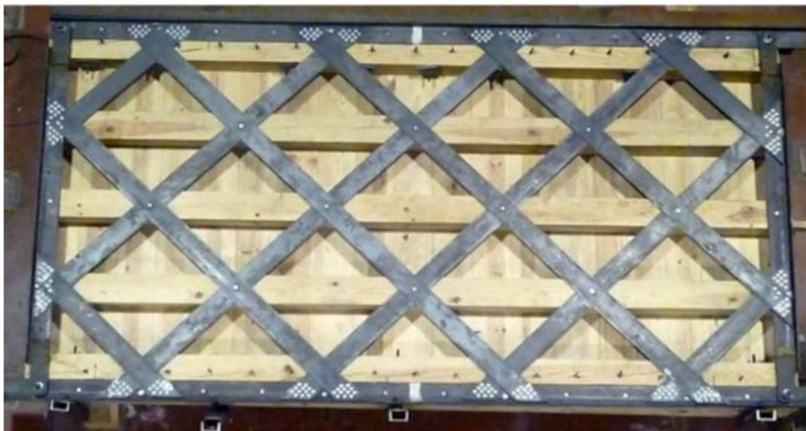
Figura 4.3 - Reforço do pavimento através da aplicação de tirantes
