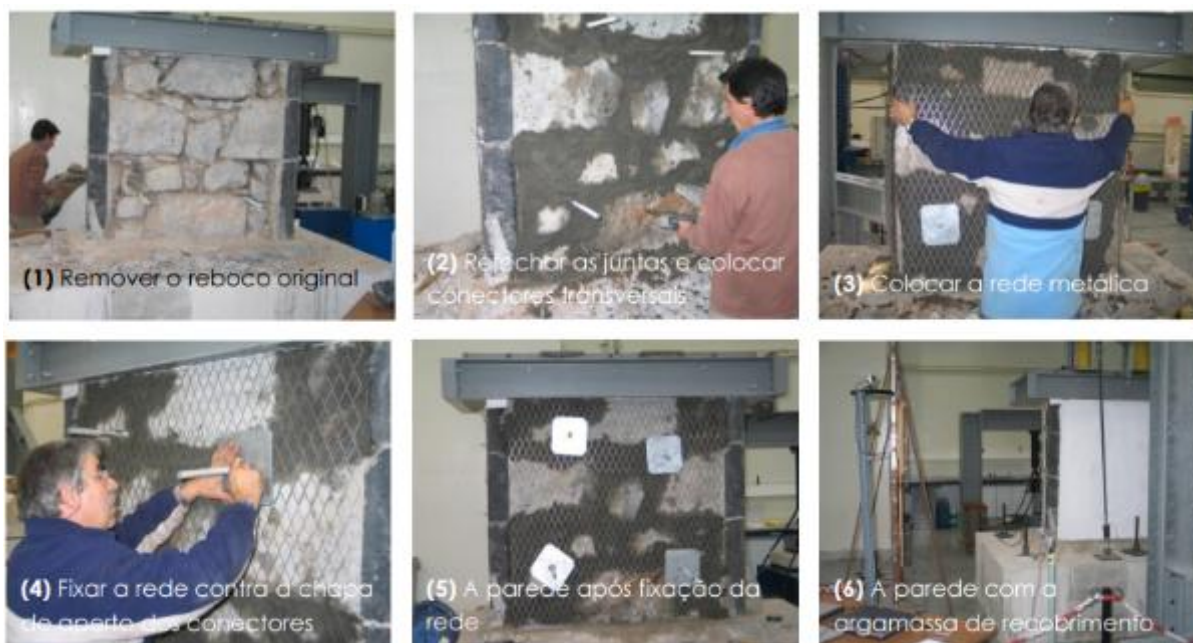
Figura 2.24 - Aplicação de reboco armado (Guedes, 2025b)
