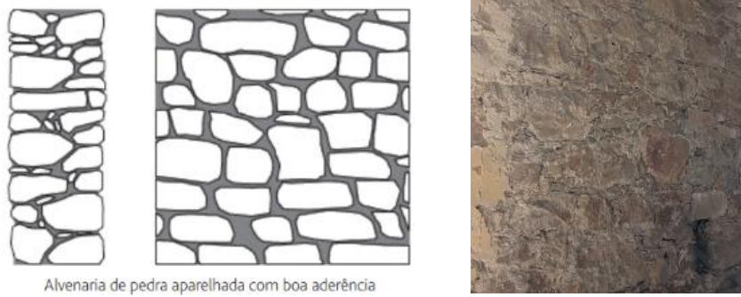
Figura 3.9 - Alvenaria de pedra aparelhada com boa aderência (Candeias et al., 2020)
