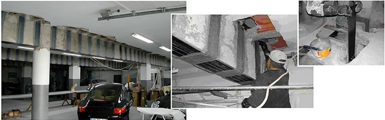
Fig. 2.2 - Técnica EBR: reforço de viga à flexão (Laminado) e ao corte (Manta) (adaptado de [15]).
