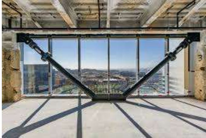
Figura 2.18 – Dispositivo de amortecimento viscoso [30].
