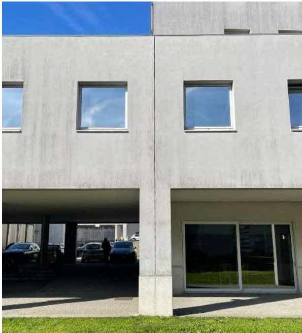
Figura 2.3 – Vista de uma junta em alçado (Faculdade de Engenharia da Universidade do Porto).
