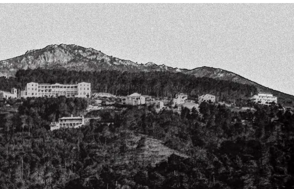
[44] A escala monumental dos edifícios sanatoriais sobre a paisagem do Caramulo, num diálogo entre o edificado e a serra.
