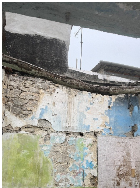
Figura 44- Fotografia do interior das ilhas de S. Vitor, durante a demolição do interior e cobertura. Fonte: Marta Sousa
