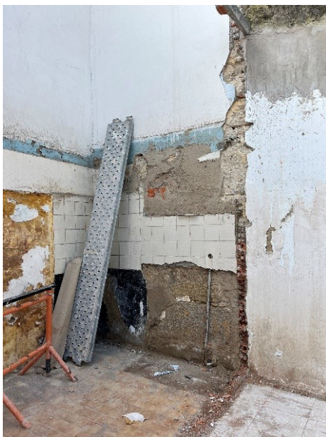
Figura 43- Fotografia do interior das ilhas de S. Vitor, durante a demolição do interior. Fonte: Marta Sousa
