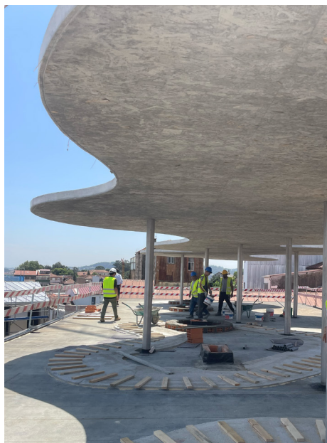
Figura 55- Fotografia obra das ilhas da Lomba, vista da cobertura do bloco C. Fonte: fotografia própria. julho de 2025
