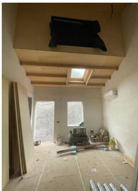
Figura 46- Fotografia do interior das ilhas de S. Vitor, durante as obras de reabilitação já em estado avançado. Fonte: fotografia própria. outubro de 2025.
