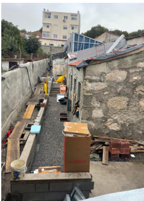
Figura 45- Fotografia do exterior das ilhas de S. Vitor, durante as obras de reabilitação. Fonte: fotografia própria. outubro de 2025.
