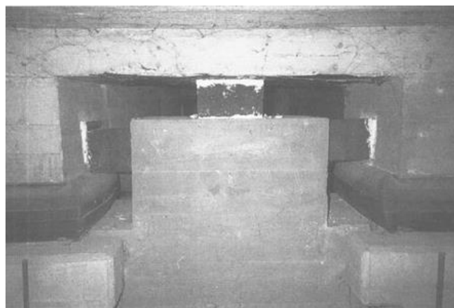
Figura 13- Vista de Blocos de Vidro- Fusíveis - 'Pestalozzi School' (Naeim & Kelly, 1999)
