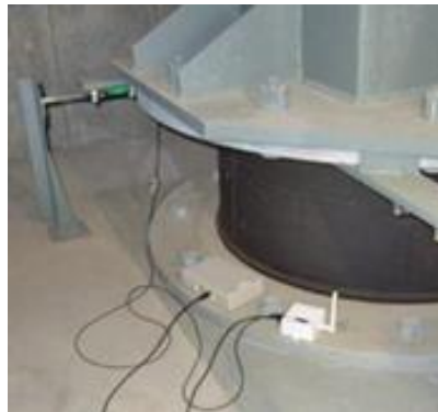
Figura 16- Dispositivo de Apoio utilizado na estrutura do “Takeda Pharmaceutical Shonan Research Center” (plantec.co.jp, 2026)
