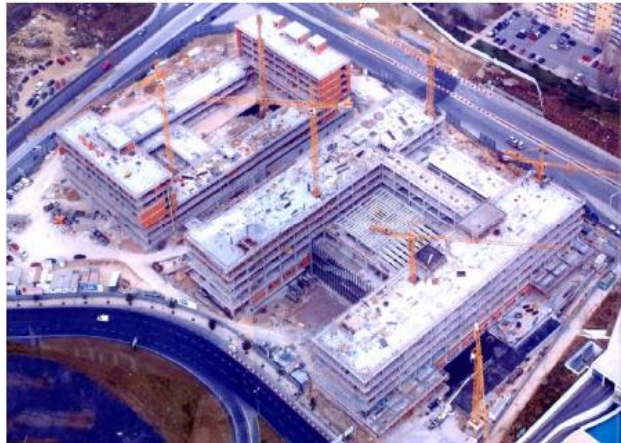
Figura 21- Vista aérea da construção do complexo do Hospital da Luz (Ferreira (n.d.))
