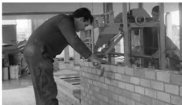
Fig.1 - O Motor Mason , em 1967, em ação, com o auxílio de pedreiros (The B1M, 2017).
