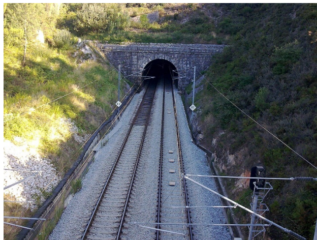
Figura 2 - Túnel do Chão de Maças (Nuno Anjos, 2009)
