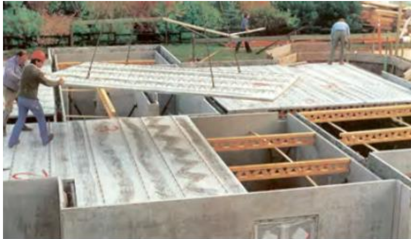
Figura 2.11 - Execução de Pré-lajes [4]
