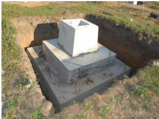
Figura 2.17 - Sapata em cálice pré-fabricada [5]
