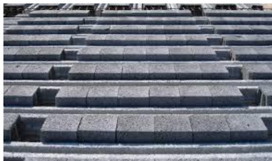
Figura 2.13 - Lajes aligeiradas [7]
