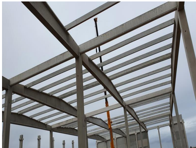
Figura 2.6 - Vigas de cobertura Pré-fabricadas [5]
