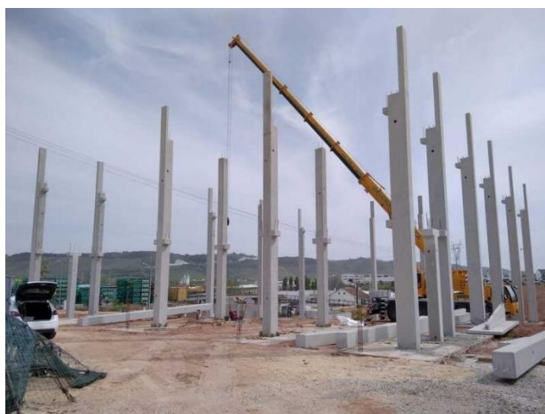
Figura 2.4 – Pilar Pré-fabricado [5]
