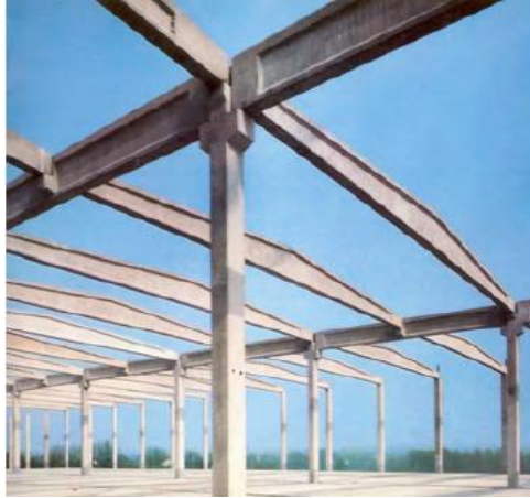
Figura 2.31 - Ligação de viga principal-viga secundária [5]
