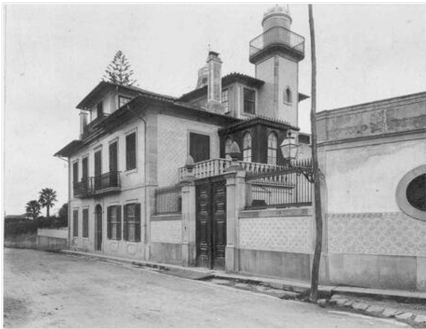
Fig. 37. e 38. Palacete, cocheira, capela e casa-anexa. Fachada norte. 1920-1925.
