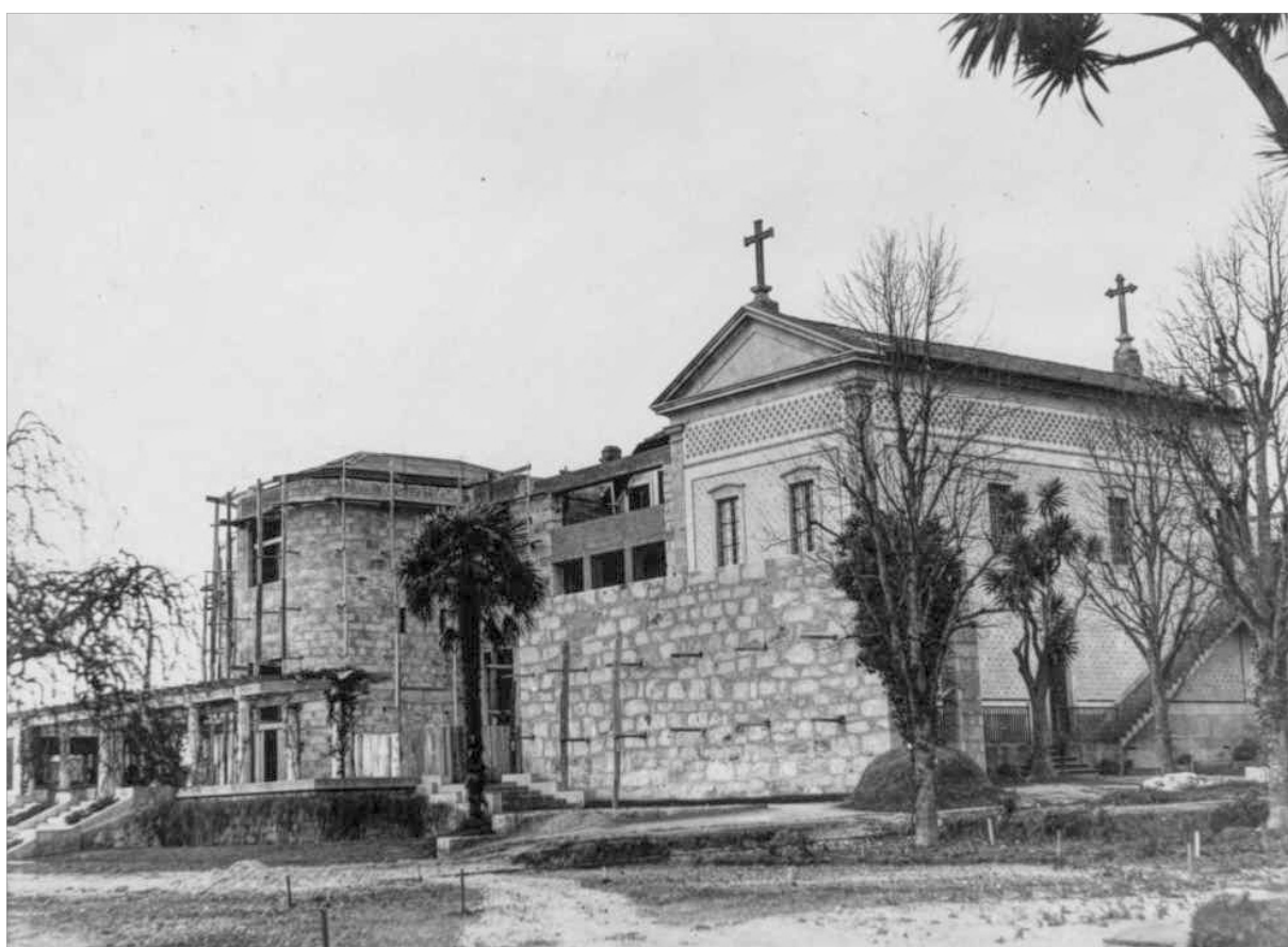
Fig. 93. Construção do sistema de camuflagem em torno da capela e da casa-anexa.
