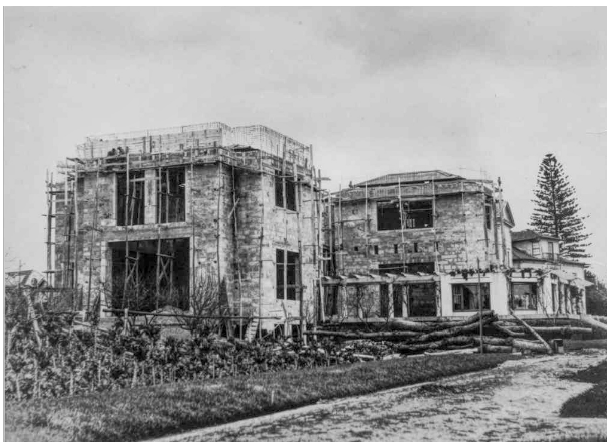
Fig. 97. Processo de construção da Casa de Serralves, onde ainda é visível a permanência da pérgola, bem como do palacete original. s.d.
