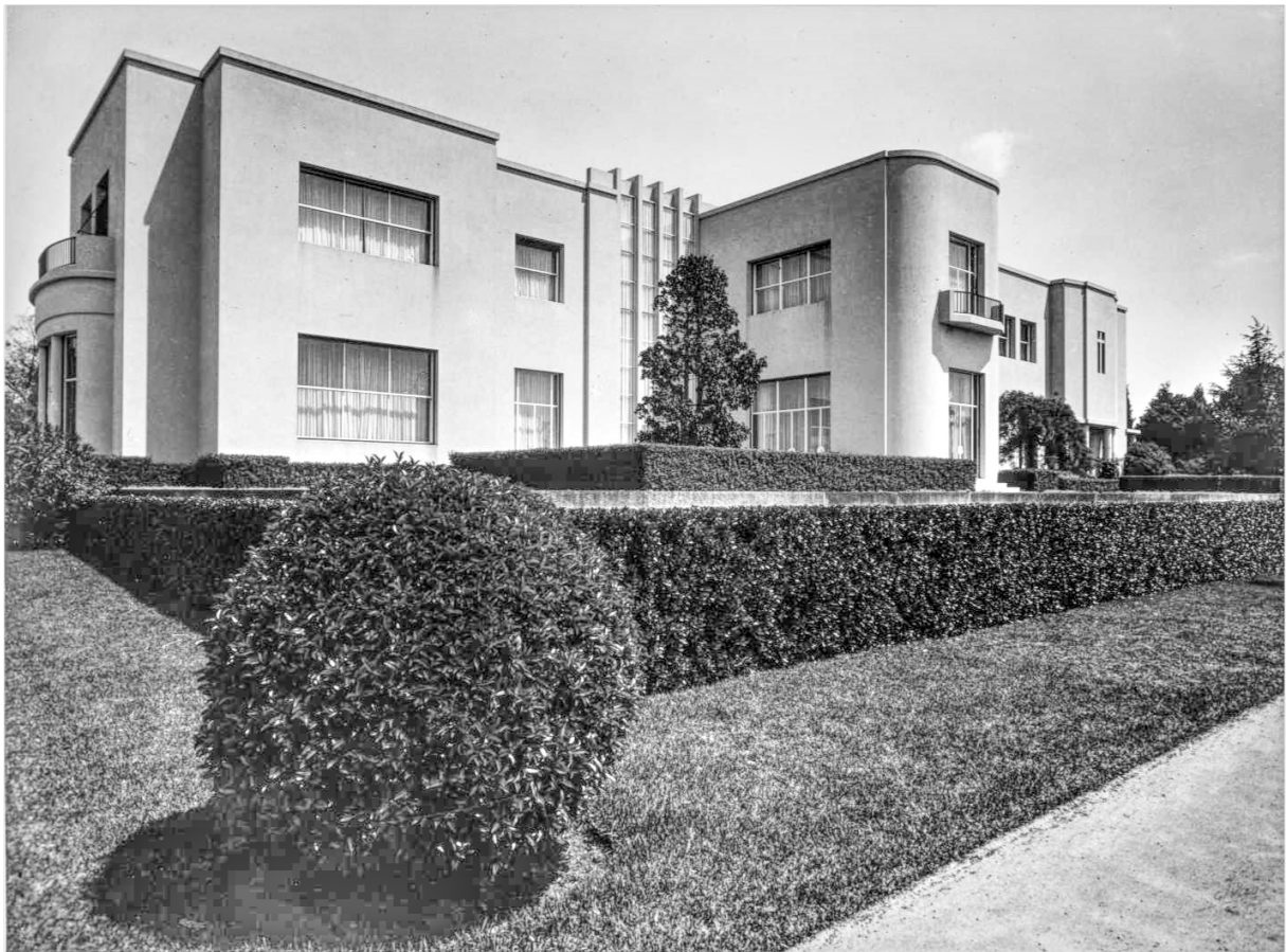
Fig. 149. Vista das fachadas sul e poente da Casa de Serralves. s.d.
