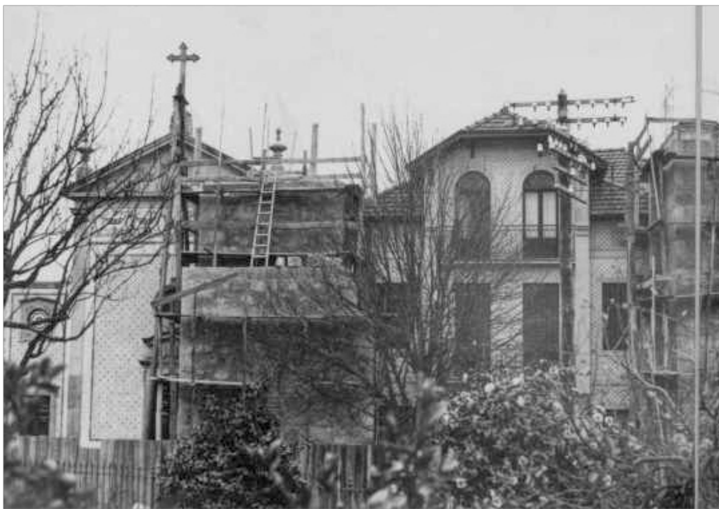
Fig. 101. Processo de construção da Casa de Serralves, onde ainda é visível o sistema de camuflagem em torno casa capela e da casa-anexa. s.d.
