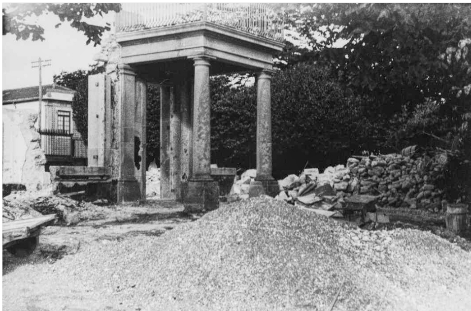
Fig. 128. Palacete original de Serralves demolido. s.d.
