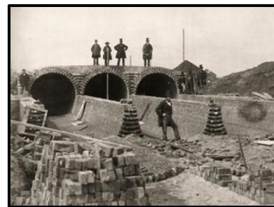
Figura 9 – prova três: rede de saneamento
