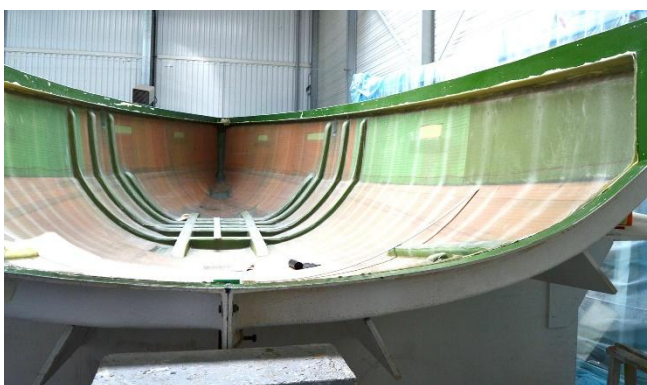
Fig. 46 - Moldagem a fibra de vidro
