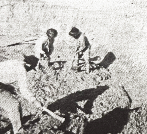
Fig. 21 Extraindo o barro, amassando e moldando. Arquitetura Popular em Portugal.
