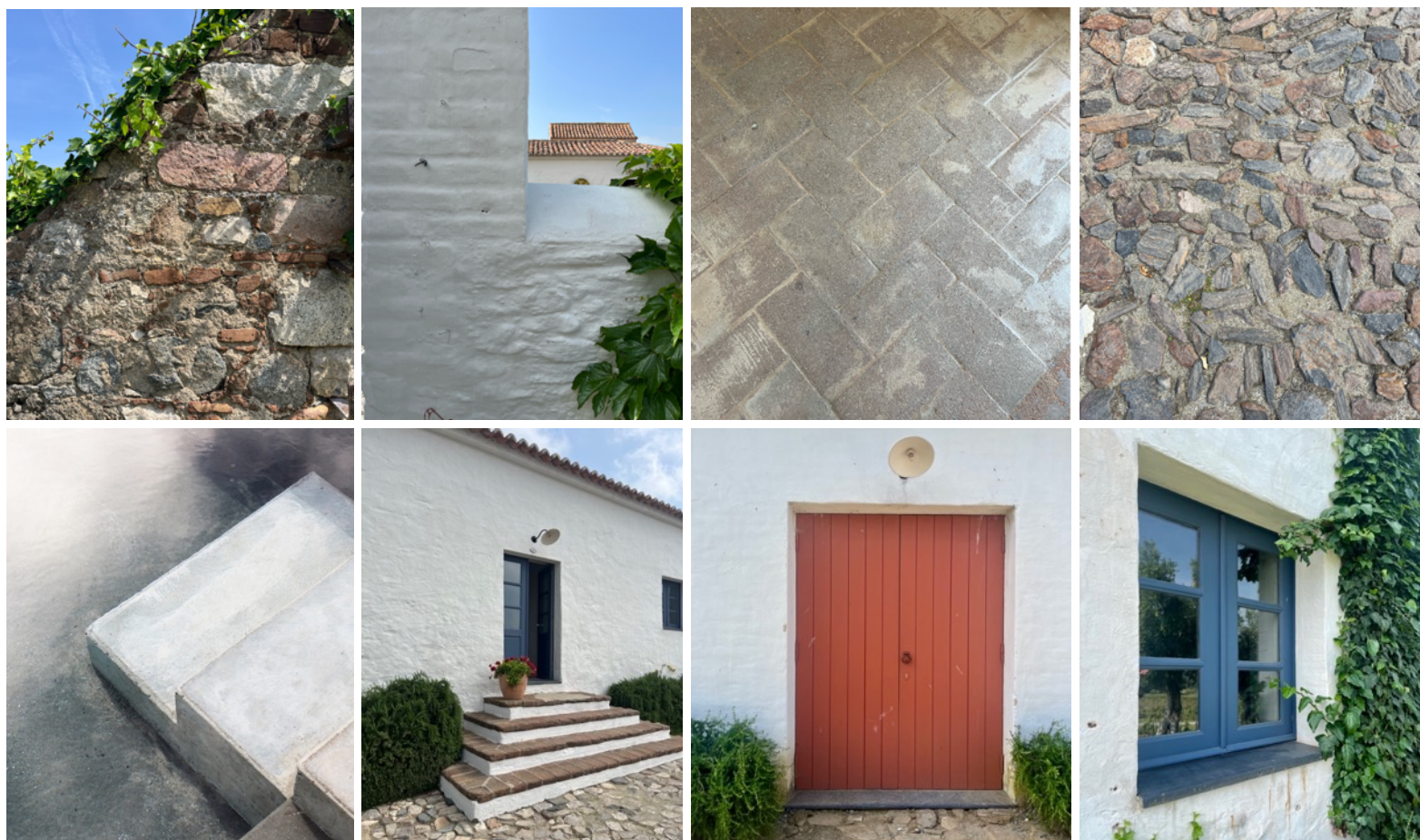
(em cima) Fig. 56 Parede Preexistente Praça de Touros. Fig. 57 Parede Pedra Revestida a Cal. Fig. 58 Pavimento Interior. Tijolo Baluarte. Fig. 59 Calçada Exterior Irregular Mista.
