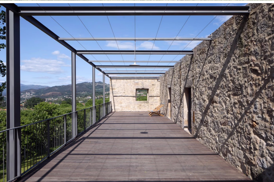
Fig. 92 Telhado preexistência. Quinta do Outeiro.
