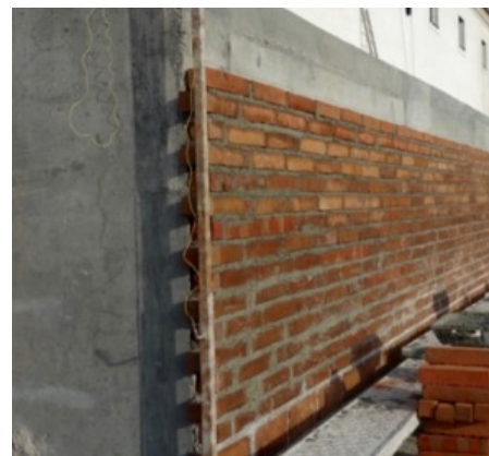
Fig. 5 Estrutura em betão forrada com tijolo de terra. São Lourenço do Barrocal
