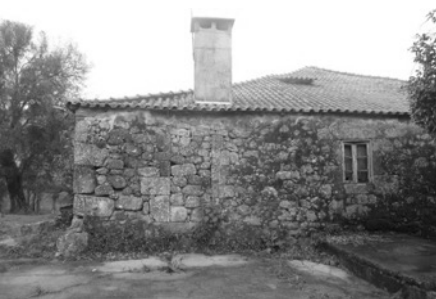
Fig. 16 Fachada em Granito, anterior à intervenção. Quinta do Outeiro.
