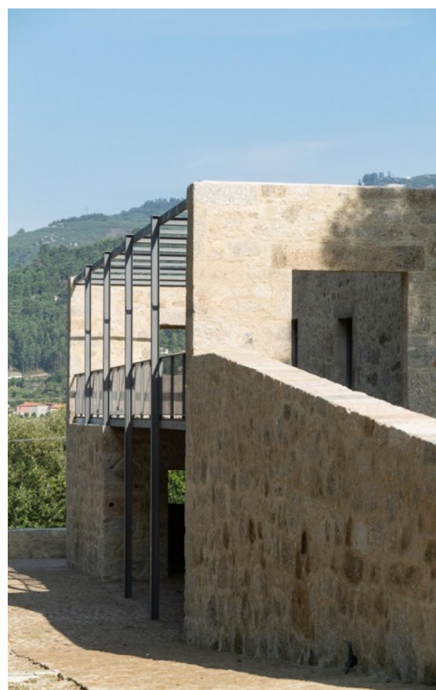
Fig. 95 Materialidade no interior. Paredes em pedra e tetos em betão pintado a branco. Quinta do Outeiro.
