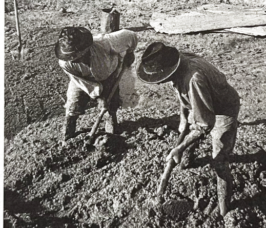
Fig. 21 Extraindo o barro, amassando e moldando. Arquitetura Popular em Portugal.
