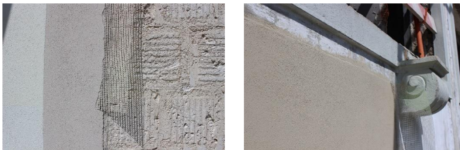
Figura 7. Protótipos executados para seleção do acabamento das fachadas do Mercado do Bolhão, em que o reboco foi preservado e aplicado barramento fino, armado.
