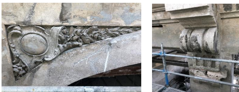
Figura 8. Exemplo de relevos em que foi executada a correção volumétrica.
