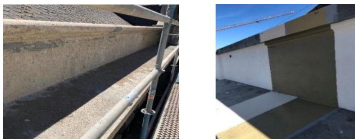
Figura 9. Tratamento da superfície da platibanda e amostras do tratamento em fase de preparação da obra.
