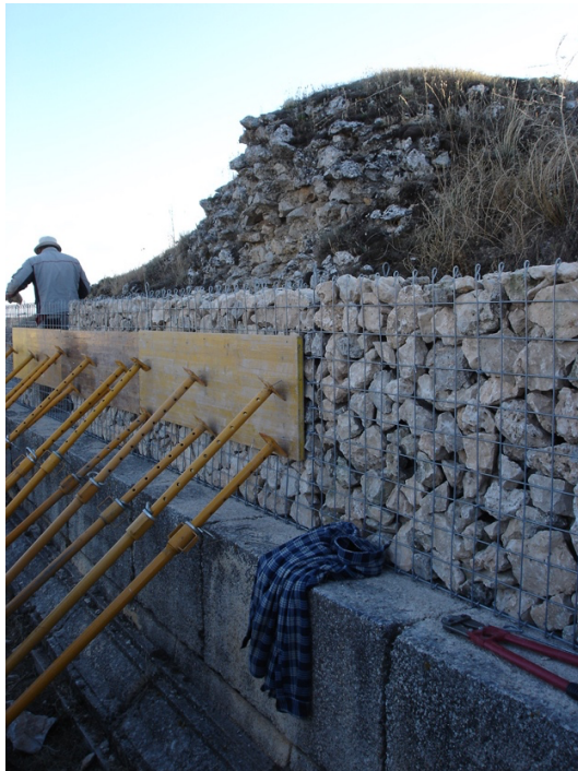
Figura 5. Consolidação estrutural. Clunia, Espanha
