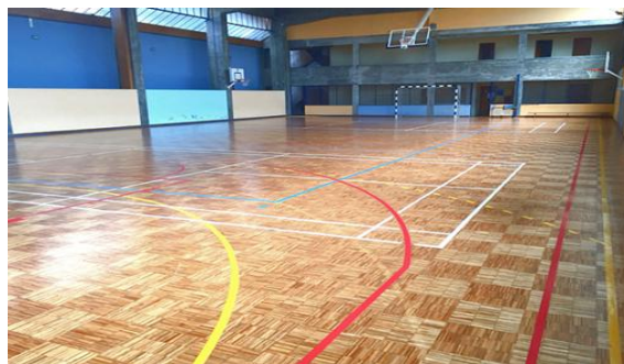
Figura 6. Pavilhão Perpétuo Socorro.
