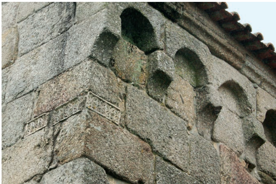
Cabeceira. Pormenor da cornija sobre arquinhos e reaproveitamento de friiso
