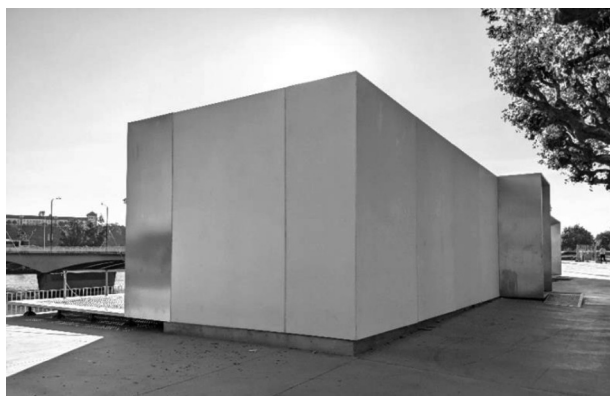
Fig 180 _ Edifício, em Coimbra (GF, 2023)
