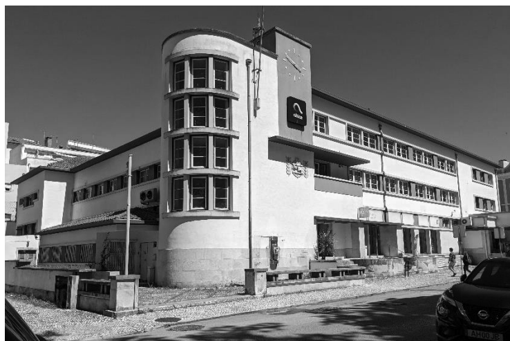
Fig 81 _ Estação dos Correios, em Figueira da Foz (GF, 2022)
