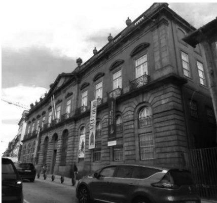
Fig 26 _ Museu Soares dos Reis, no Porto (remodelação por Fernando Távora) (GF, 2021)
