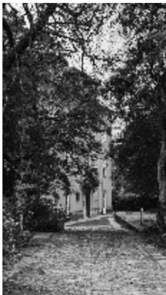
Fig 126 _ Casa côr de Rosa, no Porto (por Álvaro Siza Vieira) (GF, 2023)
