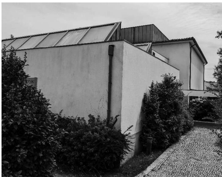
Fig 113 _ Fundação Júlio Resende, em Gondomar (por José Carlos Loureiro) (GF, 2023)
