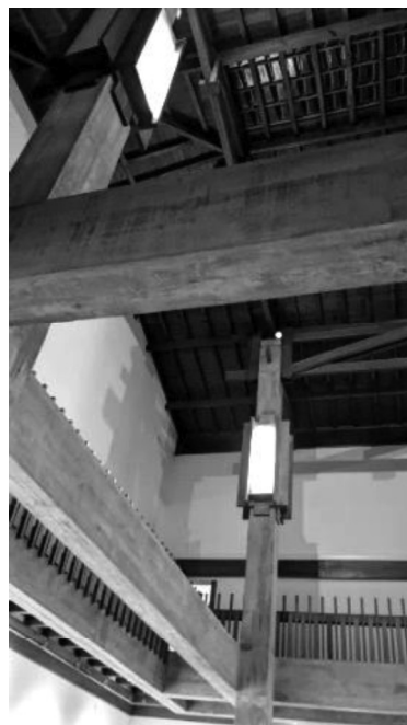
Fig 104 _ Conservatório de Música, em Aveiro (por José Carlos Loureiro) (GF, 2023)
