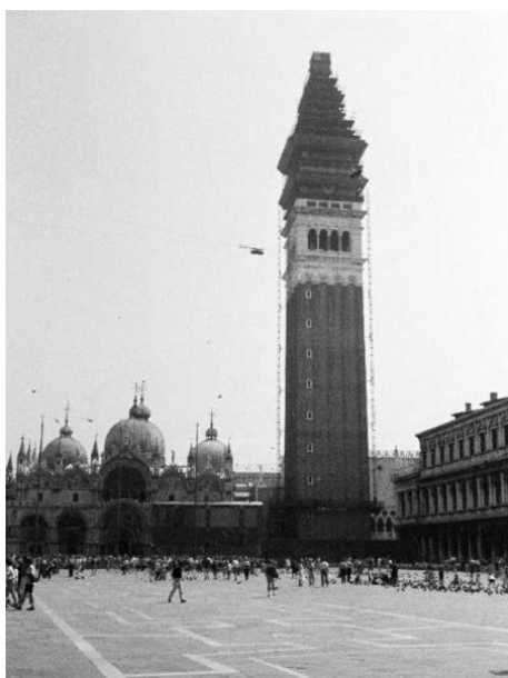
Fig 214 _ Praça de São Marcos, em Veneza (GF, 1994)
