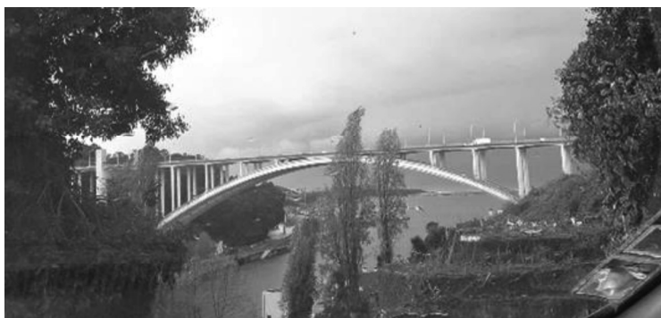
Fig 107 _ Ponte da Arrábida, no Porto (por Edgar Cardoso) (GF, 2000s)
