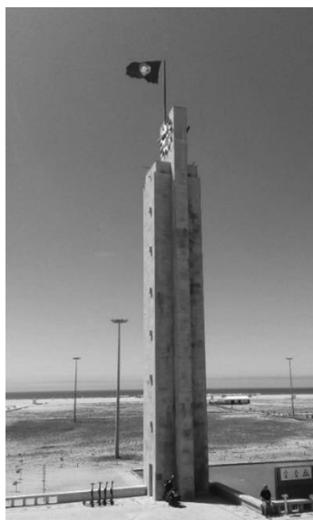
Fig 77 _ Relógio, na Figueira da Foz (GF, 2019)
