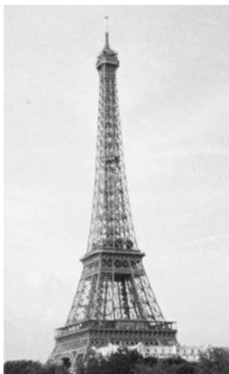
Fig 241 _ Torre, em Paris (por Gustave Eiffel) (GF, 2004)
