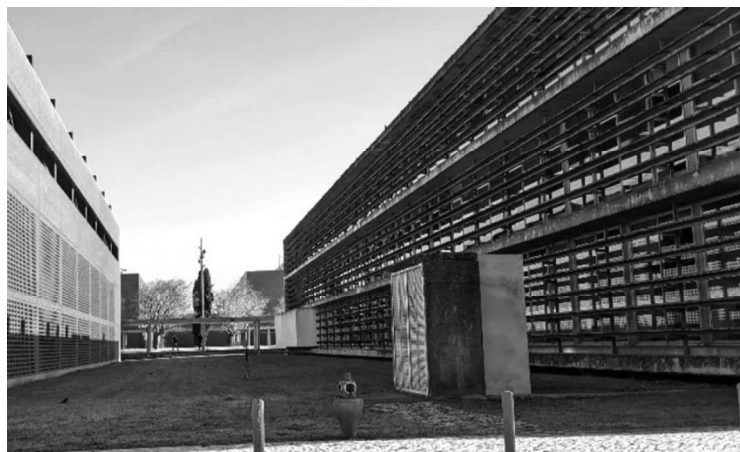
Fig 131 _ Edifício universitário, em Aveiro (por Souto de Moura) (GF, 2023)
