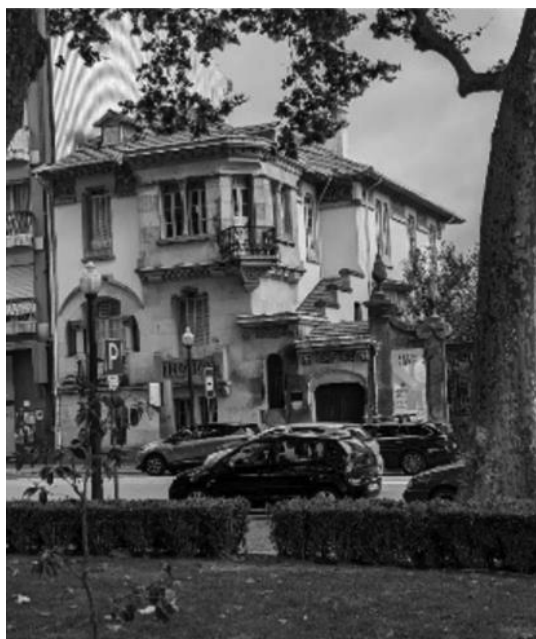
Fig 47 _ Casa-atelier, no Porto (por Marques da Silva) (GF, 2023)
