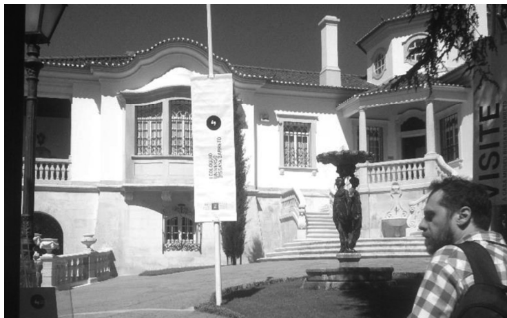
Fig 75 _ Casa Bissaya Barreto, em Coimbra (GF, 2015)
