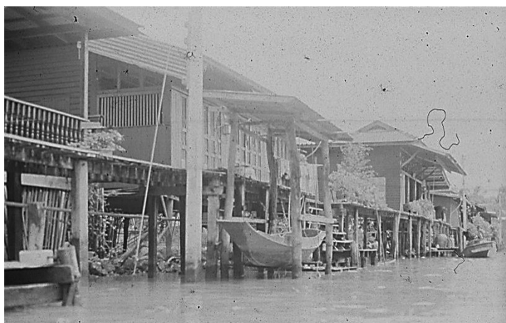
Fig 196 _ Construção, na Tailândia (GF, 1990s)
