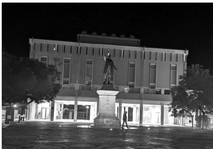
Fig 106 _ Complexo municipal, em Aveiro (por Fernando Távora) (GF, 2021-22)
