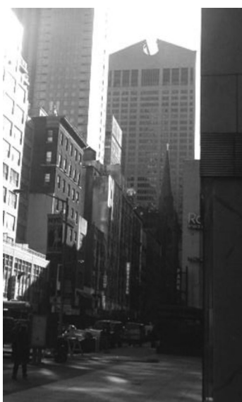
Fig 274 _ Torre AT&T, em Nova Iorque (por Phillip Johnson) (GF, 2015)
