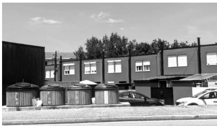
Fig 108 _ Bairro habitacional, no Porto (GF, 2023)
