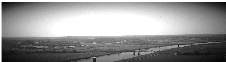
Fig 43 _ Ponte, em Alcácer do Sal (por Gustave Eiffel) (GF, 2018)
