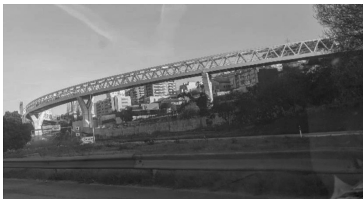
Fig 178 _ Viaduto, em Vila Nova de Gaia (GF, 2024)
