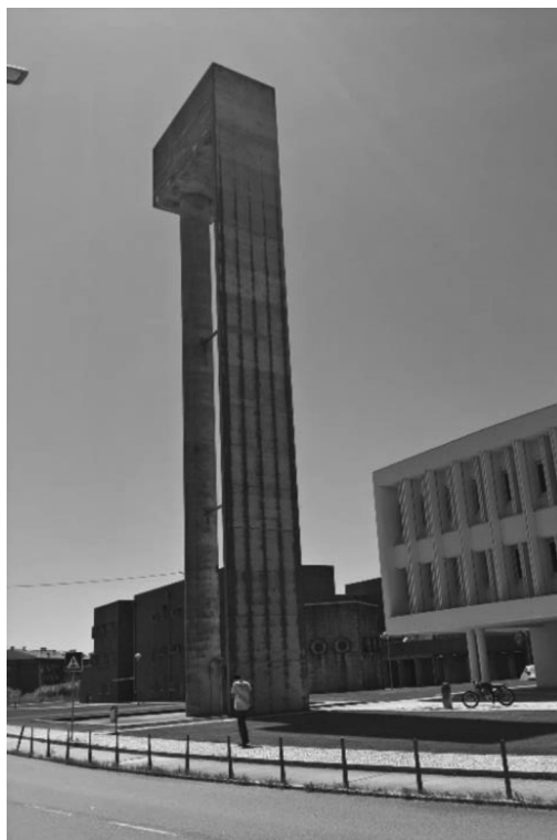
Fig 132 _ Depósito de água, em Aveiro (por Siza Vieira) (GF, 2017)
