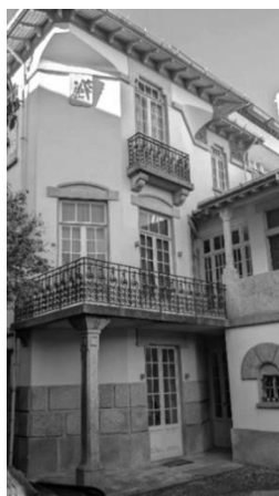
Fig 48 _ Casa atelier, no Porto (por Marques da Silva) (GF, 2023)
