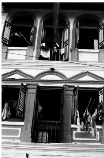
Fig 282 _ Edifício, em Singapura (GF, 1990s)
