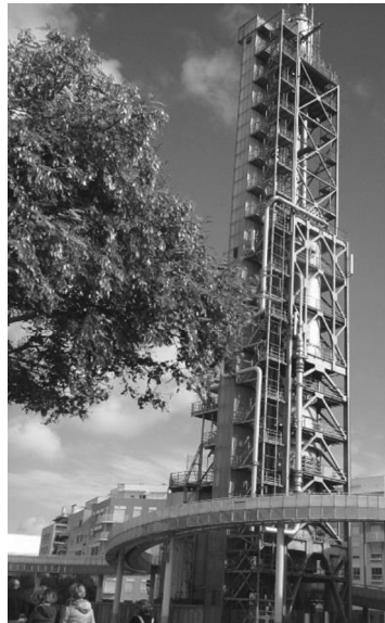
Fig 147 _ Torre na Expo 98, em Lisboa (por Manuel Graça Dias) (GF, 2018)
