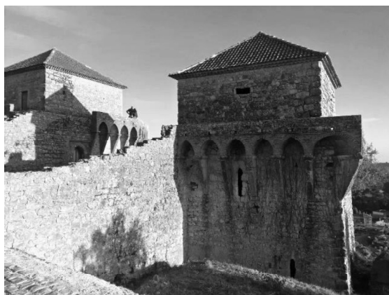
Fig 9 _ Castelo, em Óbidos (GF, 2018)
