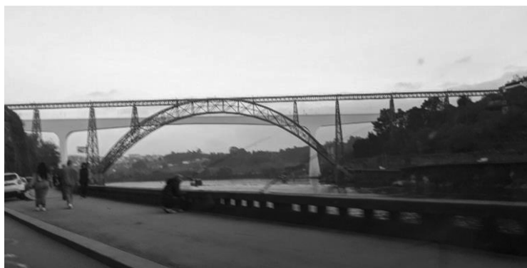
Fig 44 _ Ponte de ferro, no Porto (GF, 2023)
