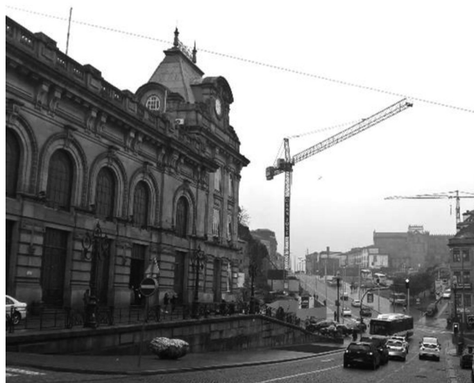
Fig 46 _ Estação de São Bento, no Porto (por Marques da Silva) (GF, 2018)
