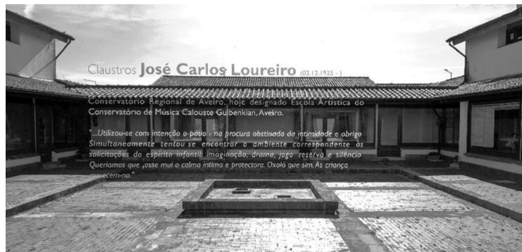
Fig 103 _ Conservatório de Música, em Aveiro (por José Carlos Loureiro) (GF, 2023)
