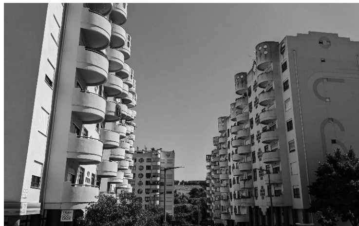
Fig 125 _ Bairro, em Coimbra (GF, 2023)
