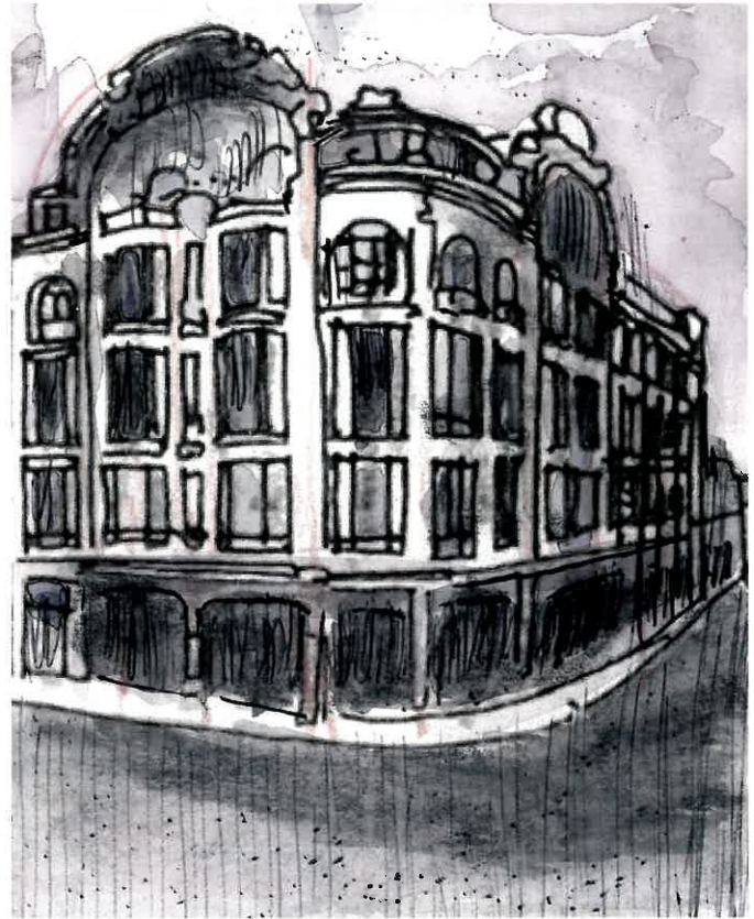
Marques da Silva, Armazéns Nascimento, Porto, ca.1900-20s
