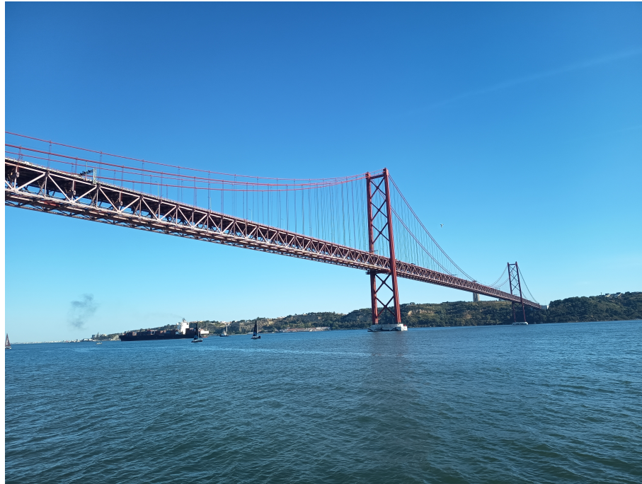
Figure 3.6: The 25 de Abril bridge.
