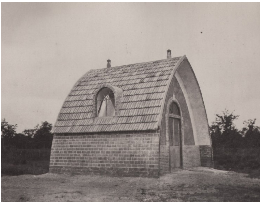
043. Construção experimental de enfermaira isolada, Tollet. | Fotografias interior e exterior.
