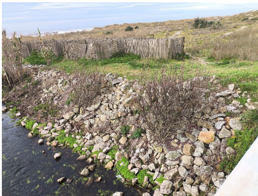
Figura 16 – Enrocamento vivo
