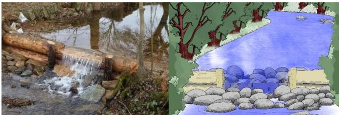
Figura 10 – Exemplo de travessão em pedra e madeira (E.Rio, 2025)
