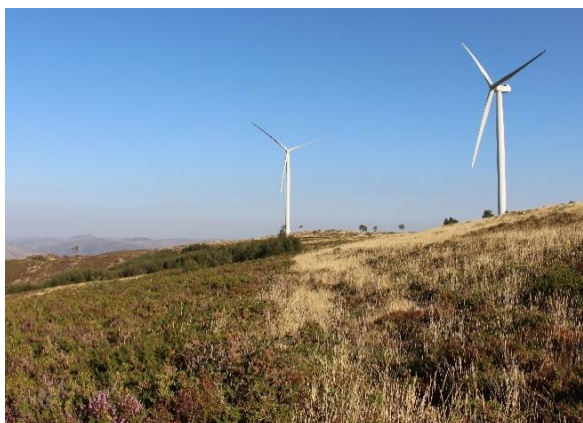
Figura 12 - Transição entre zonas intervencionadas (corte) e zonas naturais na área de estudo 6
