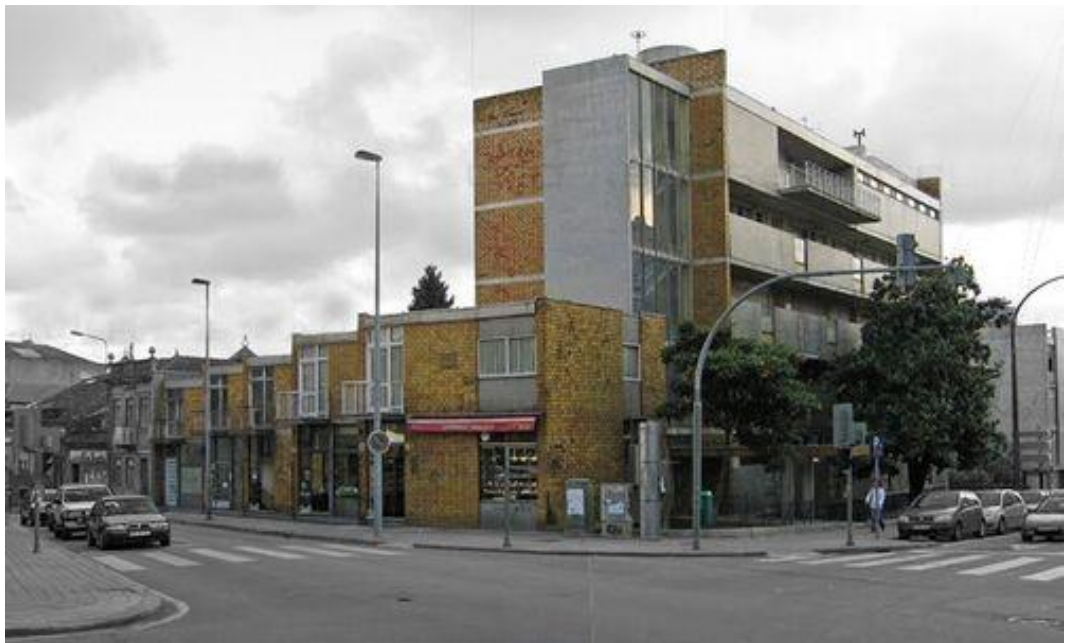
Imagem 31: Edifício Parnaso, Porto
