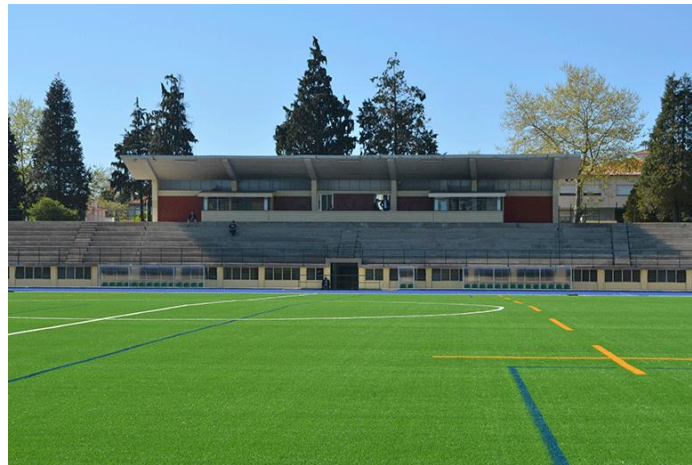
Figura 2 - Parque Desportivo de Ramalde (INATEL)
