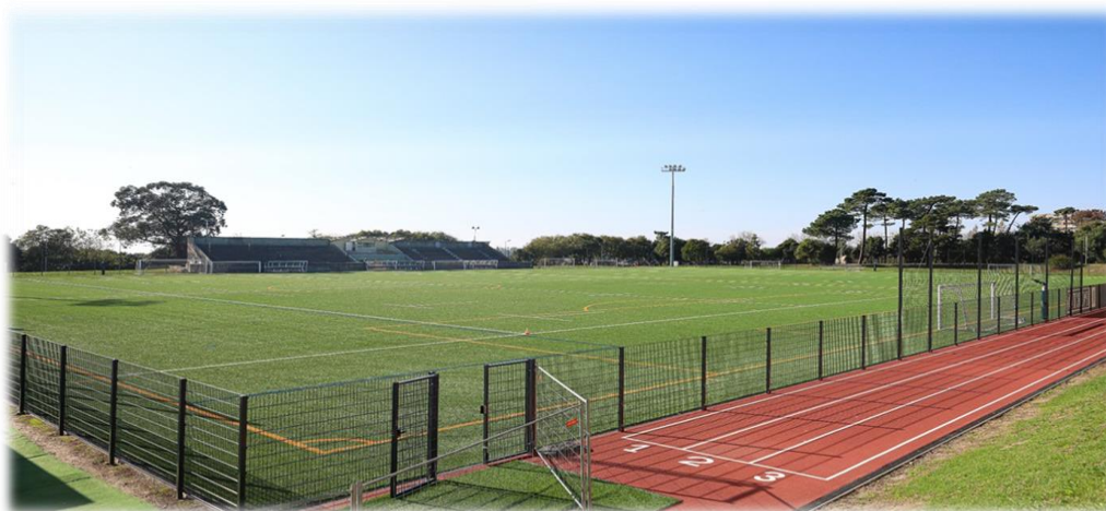
Figura 9 - Centro de Desporto da Universidade do Porto (CDUP).
