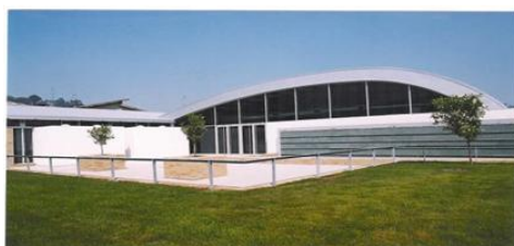
Figura : Instalação da Piscina Municipal Coberta Fonte: Arquivo Municipio da póvoa de Lanhoso
