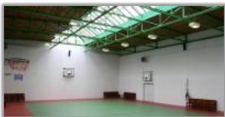
Figura 4 Sala de Desportos dos Congregados
