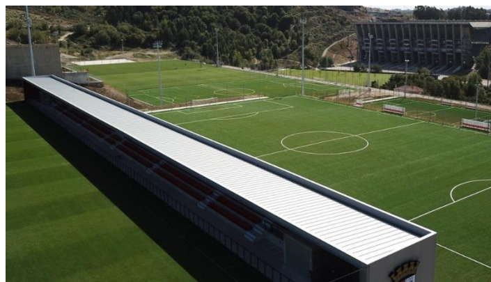
Figura 3 – Visão global dos restantes campos da Cidade Desportiva (Fonte: scbraga.pt)
