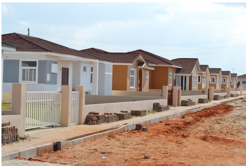
Figura 42. Projeto Intaka de 5000 Casas em Construção
