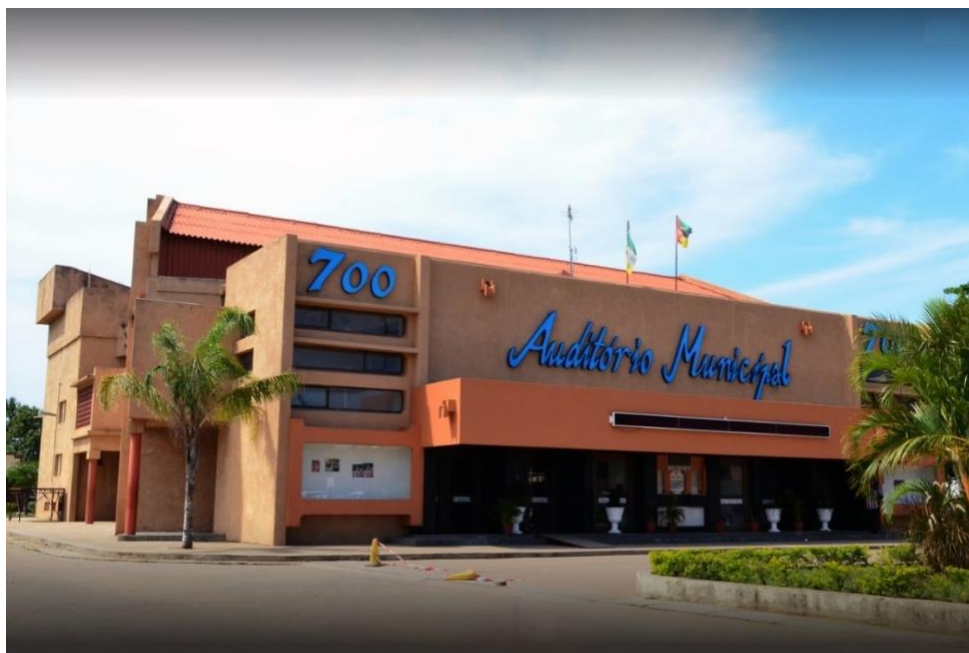
Figura 80. Auditório Municipal 700, no Bairro Matola "B"
