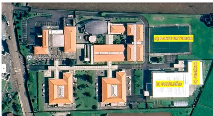
Imagem 1 – Foto da Escola Básica e Secundária – Vista aérea
