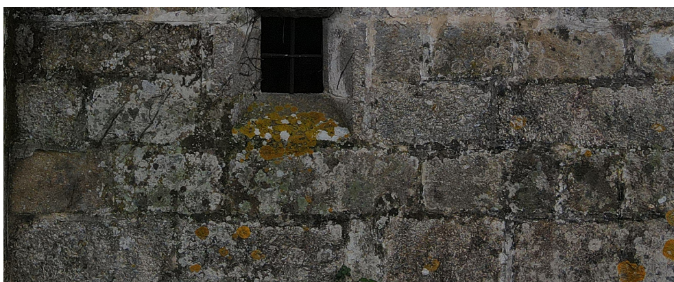
032 Aparelho de pedra da sacristia da Igreja Fotografia da autora, 2023
