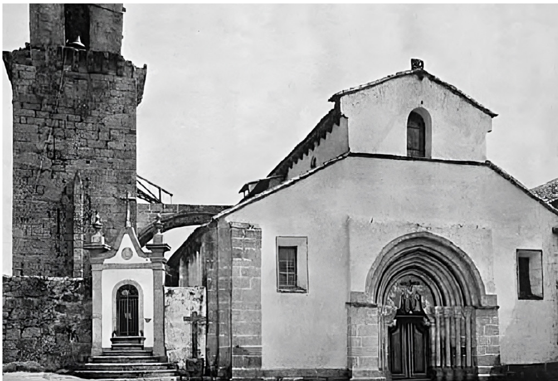
051 Mosteiro de Travanca antes dos Trabalhos da DGEMN, © Boletim nº15 DGEMN, 1939
