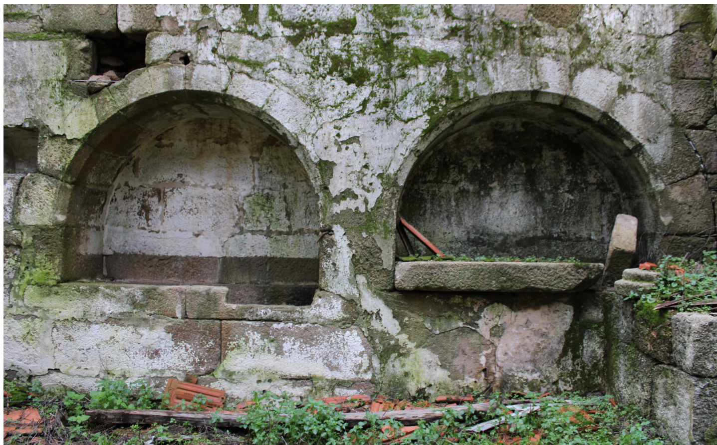
036 Arcossólios na parede norte da nave da Igreja Fotografia da autora, 2023
