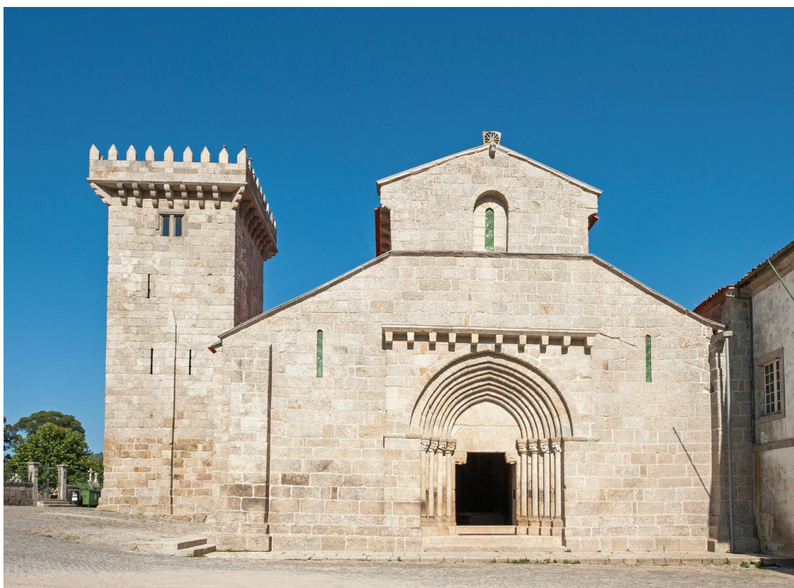
052 Mosteiro de Travanca atualmente © Rota do Românico
