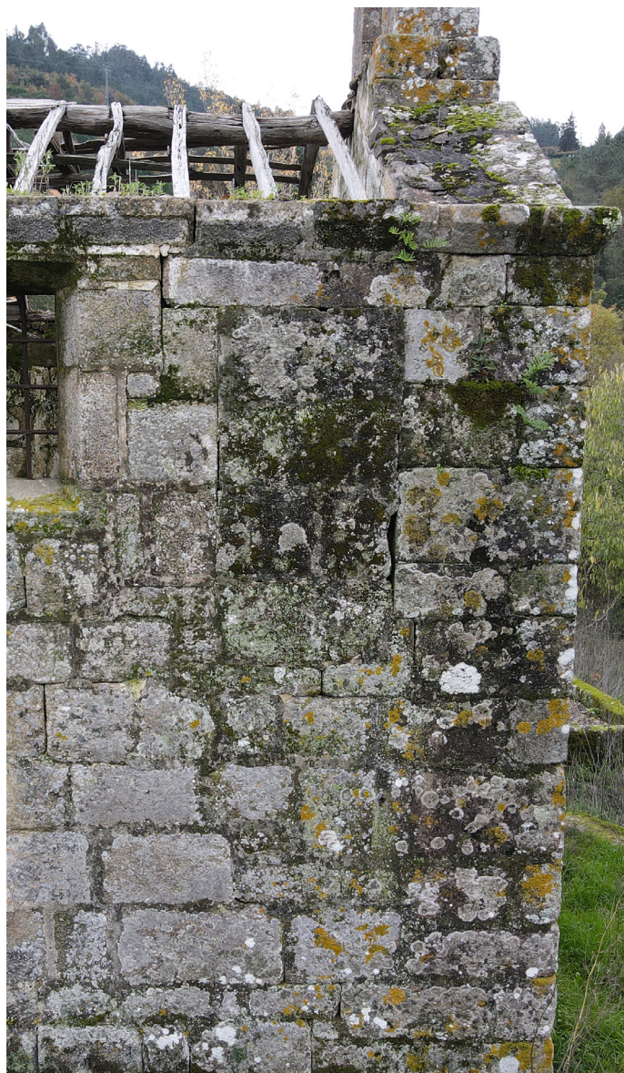
050 Indicação de uma porta na fachada norte da nave Fotografia da autora, 2023
