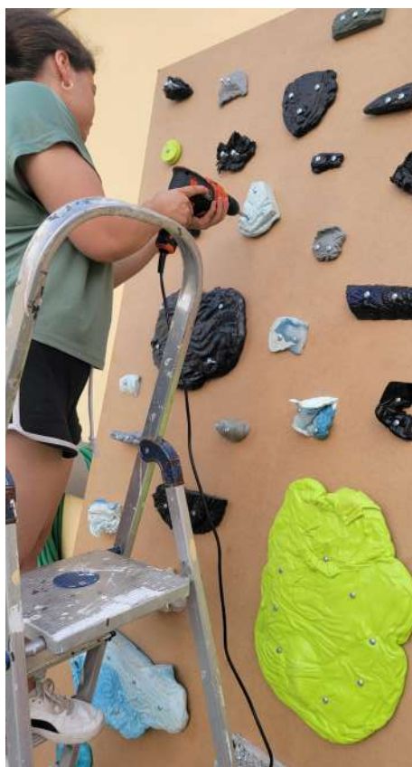
Figura 125. Fixação definitiva dos parafusos
