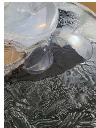
Figura 94. Aplicação da 2ª camada de resina
