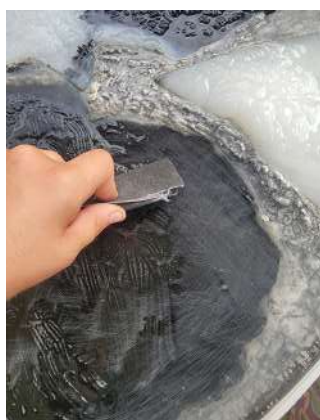
Figura 93. Lixagem da superfície (1ª camada de resina)
