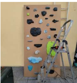
Figura 124. Posicionamento da tábua na vertical, com purgas pré-fixadas
