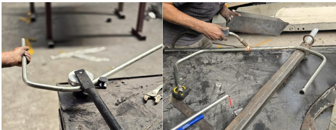
Figura 76 Fotografias do processo de curvar e soldar o tubo (fonte própria, 2025)
