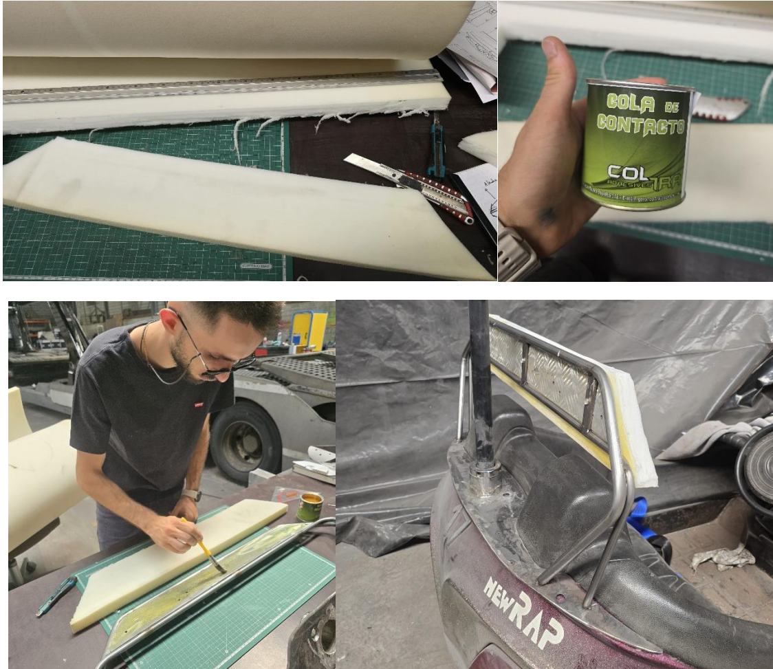
Figura 81 Conjunto de fotografias da aplicação da espuma no encosto (fonte própria, 2025)
