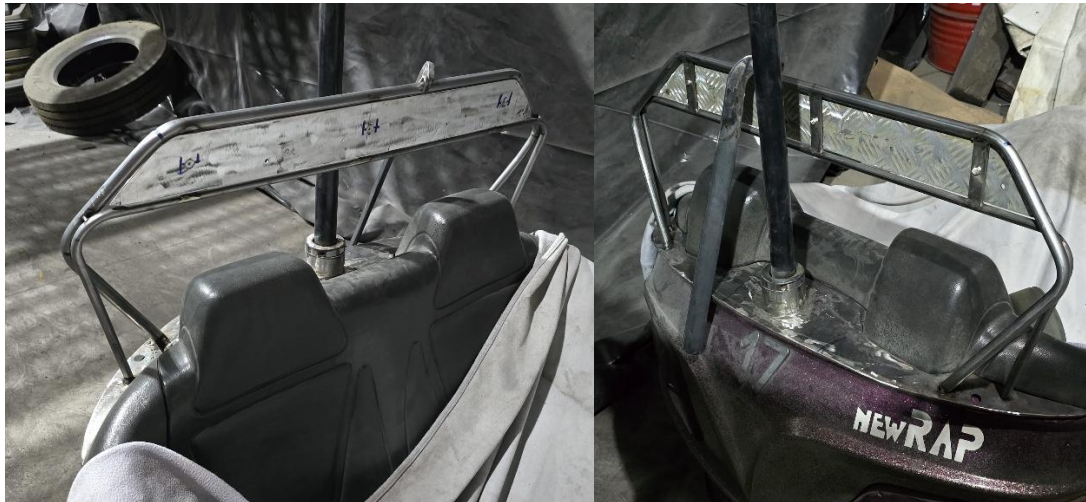
Figura 80 Conjunto de fotografias do processo de construção da estrutura (fonte própria, 2025)
