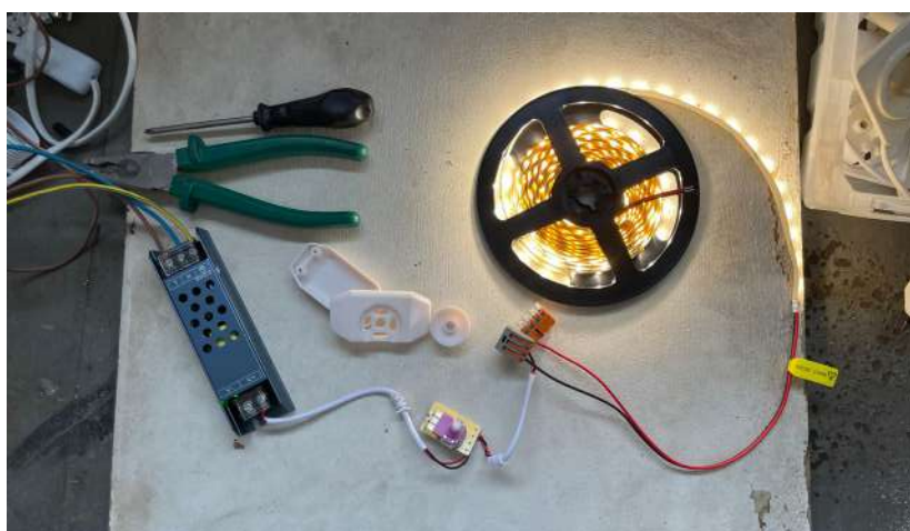
Figura 214 - Ensaio inicial da ligação elétrica. Fotografias da autoria da investigadora.
