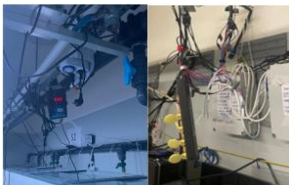
Figura 71 - Colocação de tomadas e ligação a quadros elétricos
