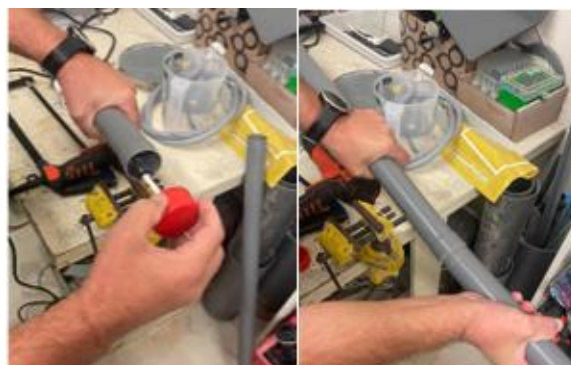
Figura 68 - Colocação de cola em tubos de PVC
