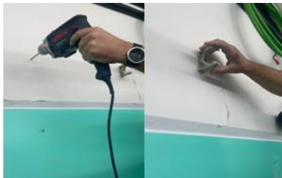
Figura 69 - Utilização de furadora
