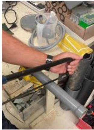
Figura 66 - Corte dos tubos de PVC com um serrote
