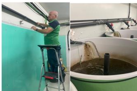
Figura 70 - Fixação dos tubos PVC
