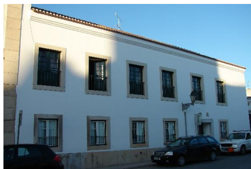
Figura 3.11 - Exterior do edifício [foto de J. Renda]
