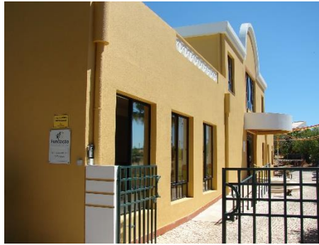
Figura 3.20 - Edifício visto do exterior [foto de J. Renda]
