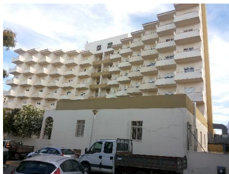
Figura 3.17 - Fachada sul do edifício [foto de J. Renda]
