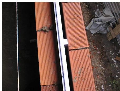
Figura 3.6 - Exemplo das paredes duplas [foto de J. Renda]
