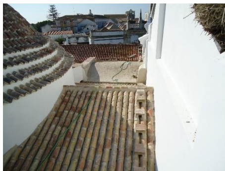
Figura 3.12 - Cobertura do edifício [foto de J. Renda]
