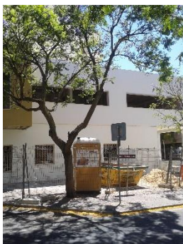
Figura 3.18 - Obra de ampliação do edifício [foto de J. Renda]
