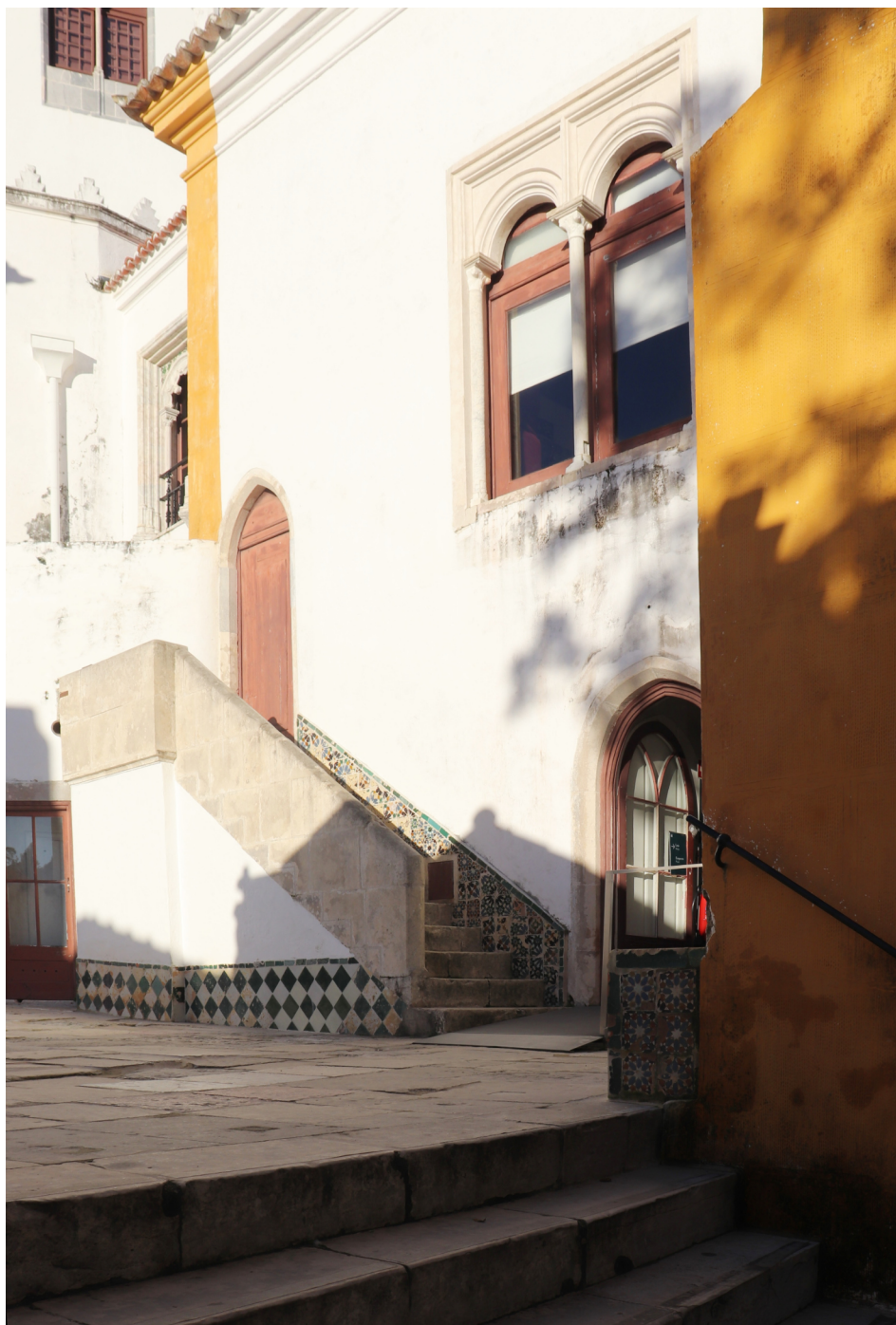
[Fig. 50] Pátio do Leão, porta de acesso à mantearia (à direita) e escadaria de ligação ao piso nobre, fotografia da autora, 2024.
