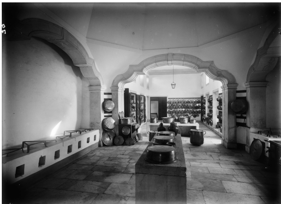
[Fig. 40] Chaminés da cozinha do Palácio dos Condes de Almada em Lisboa (Palácio da Independência), autor desconhecido, datação desconhecida. © SIPA, DOC.00009406 FOTO.00005765.
