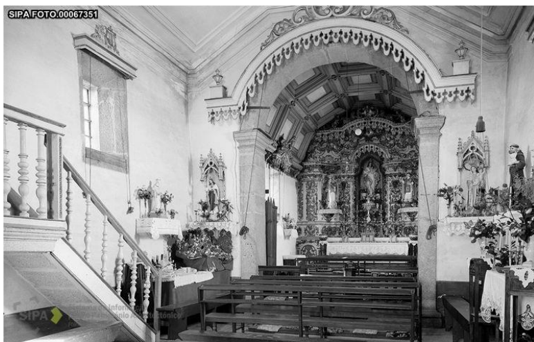
Figura 61: O interior da capela.
