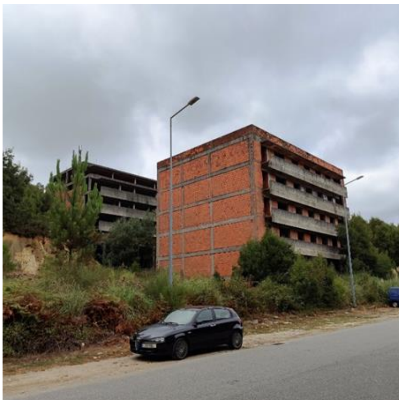
Anexo 11 - Edifício degradado na rua Nuno Tristão, freguesia de Valongo
