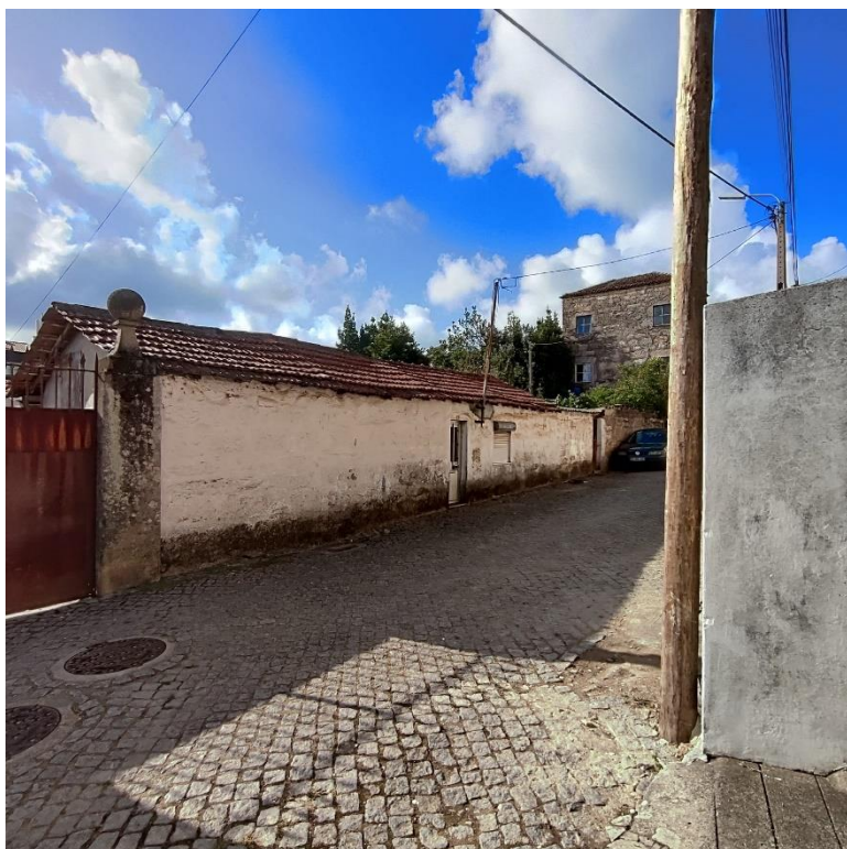
Anexo 5 - Edifício degradado na rua da Moura, freguesia de Alfena
