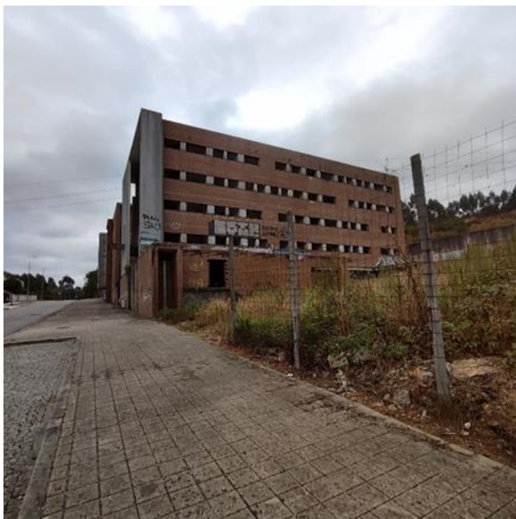
Anexo 15 - Edifício degradado na rua Vasco de Lima Couto, freguesia de Valongo
