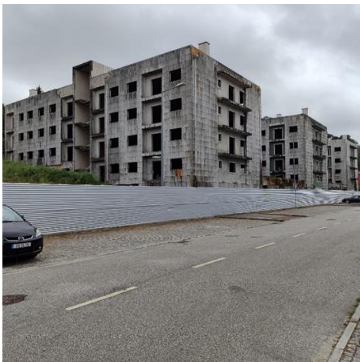
Anexo 13 - Edifício degradado na rua Regedor José Diogo, freguesia de Valongo
