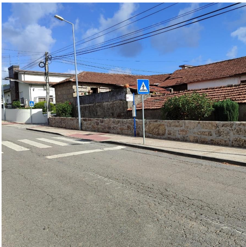
Anexo 7 - Edifício degradado na rua Nossa Senhora do Amparo, freguesia de Alfena
