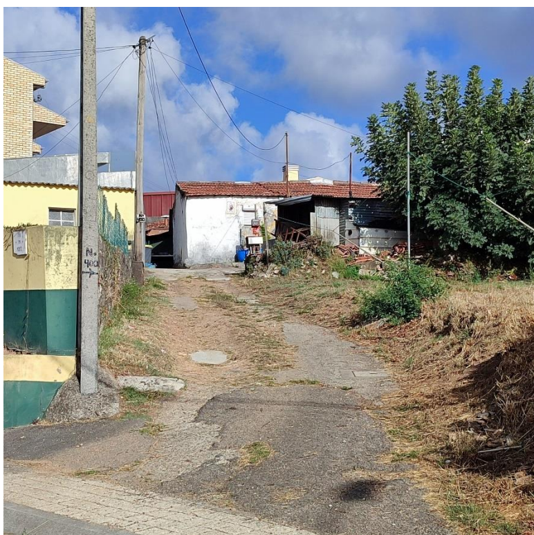
Anexo 4 - Edifício degradado na rua do Monte, freguesia de Alfena
