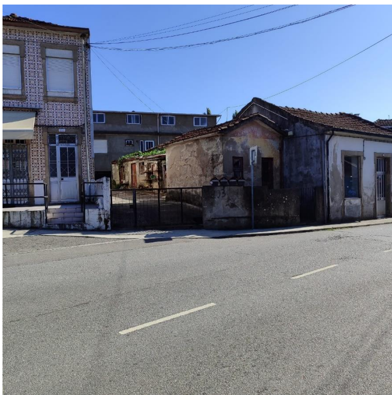
Anexo 10 - Edifício degradado na rua 5 de Outubro, freguesia de Ermesinde
