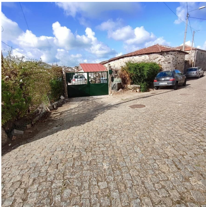
Anexo 8 - Edifício degradado na rua de São Tomé, freguesia de Alfena
