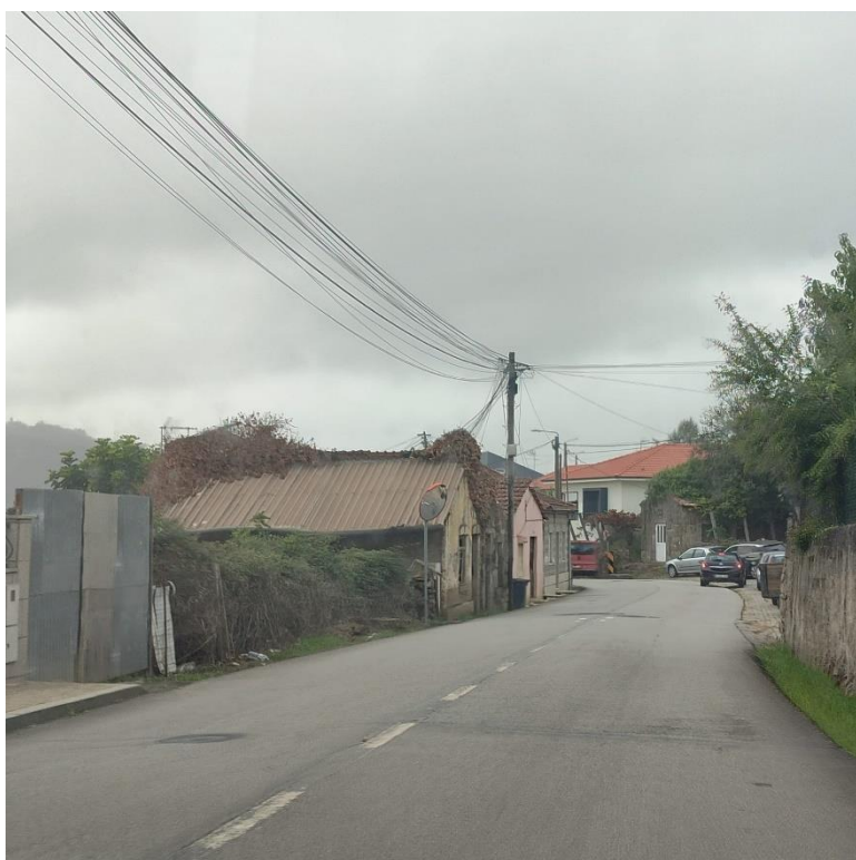
Anexo 6 - Edifício degradado na rua Nossa Senhora do Amparo, freguesia de Alfena
