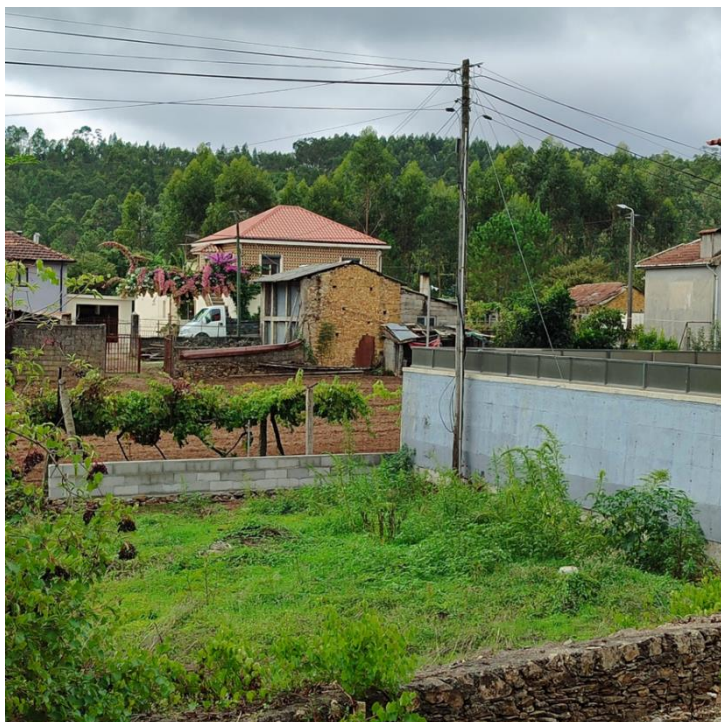
Anexo 27 - Edifício degradado na rua da Aldeia, União de freguesias de Campo e Sobrado (Sobrado)
