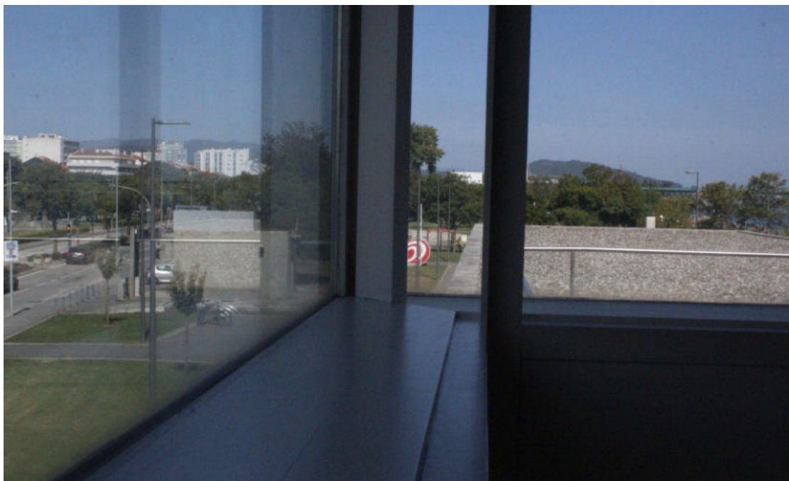
Biblioteca municipal de Viana do Castelo pormenor da espessura da parede
