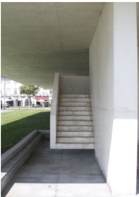
Biblioteca municipal de Viana do Castelo escadas de incêndio
