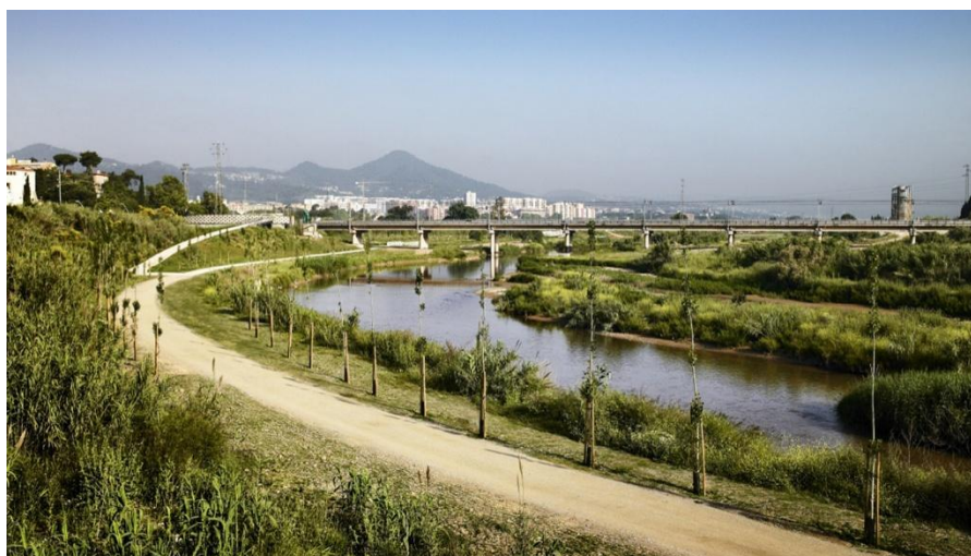
Figure 51 - Parque Fluvial de Llobregat (Espanha). (fonte: archdaily)
